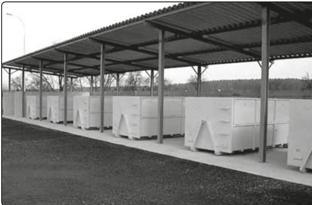
Září – říjen 2008: Dokončení zemních prací, stavba přístřešků, vybavení předepsanými kontejnery
