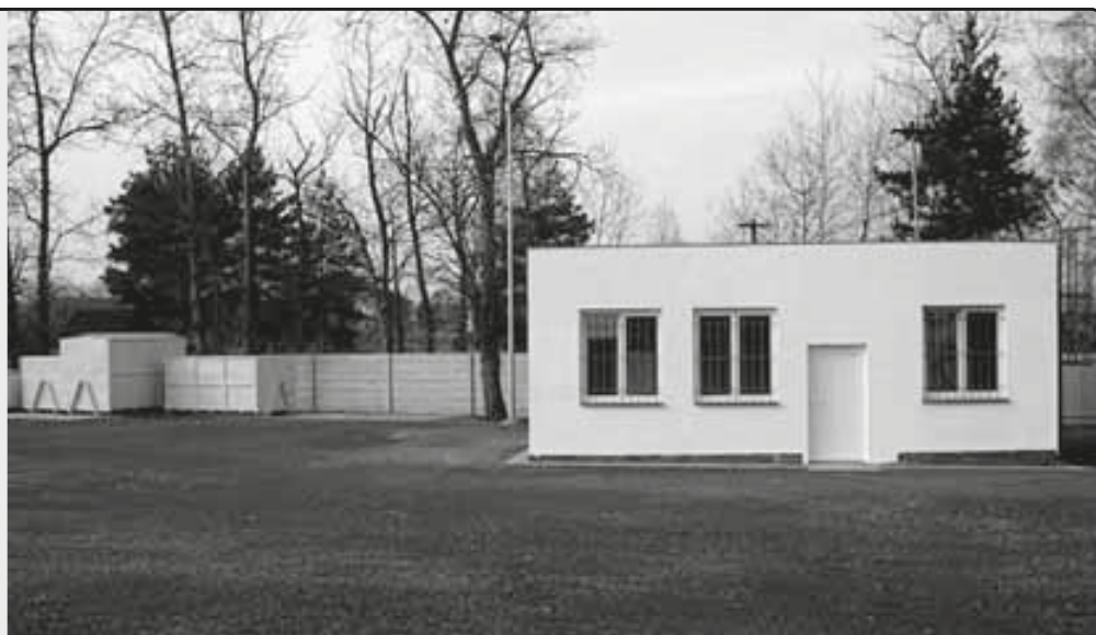
Říjen – listopad 2008: Rekonstrukce objektu pro obsluhu sběrného dvora
