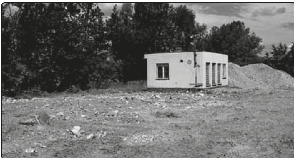
Srpen 2008: Areál po ukončení demoličních prací
