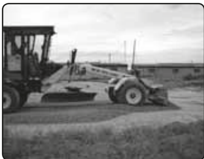
Zemní práce při výstavbě víceúčelového sportoviště
