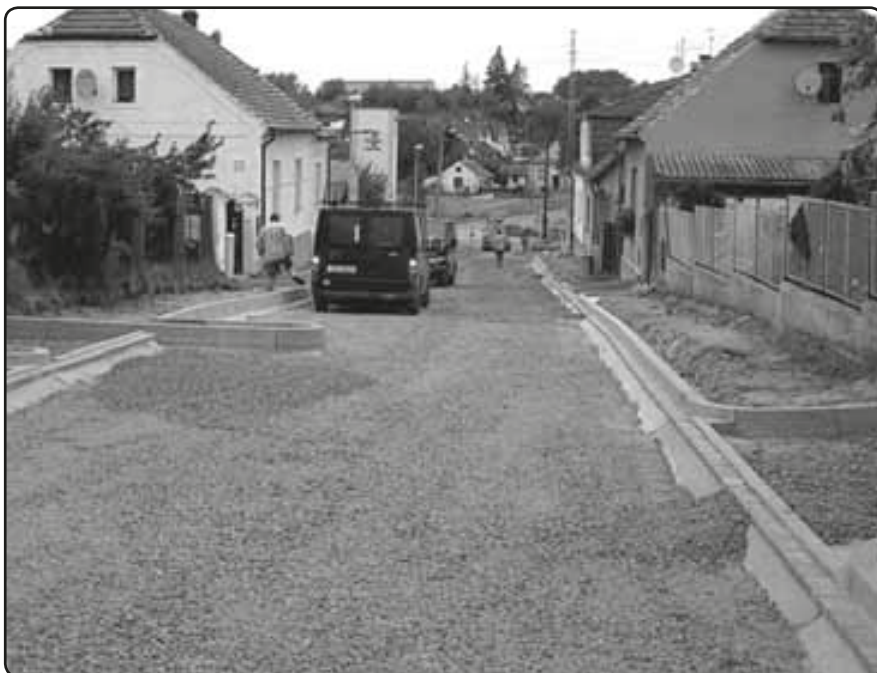
Stav prací v Tlučenské ulici na začátku září
