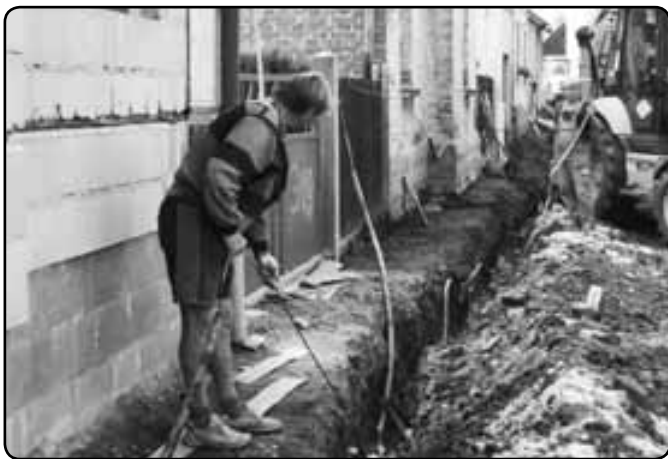
Přeložka telefonního kabelu (srpen 2010)
