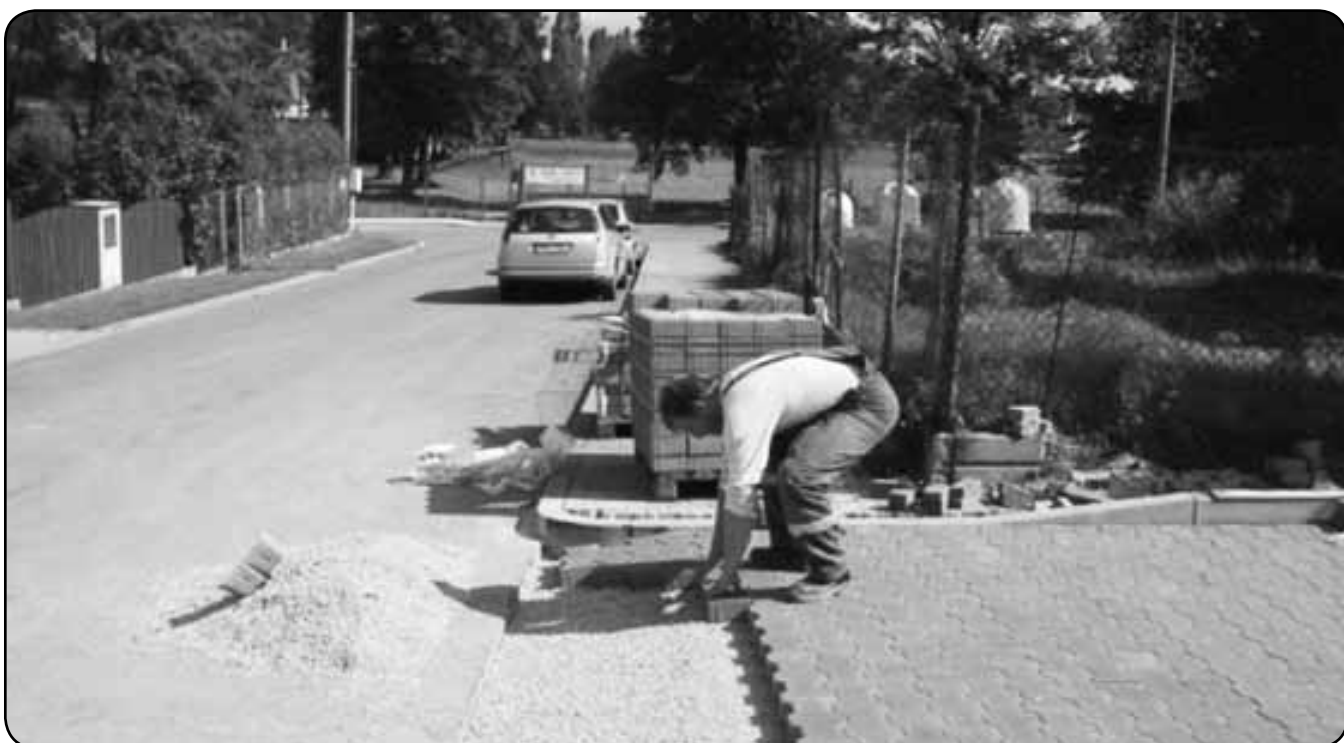
Dláždění koncového úseku komunikace (září 2010)
