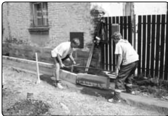
Osazování silničních obrub (srpen 2010)
