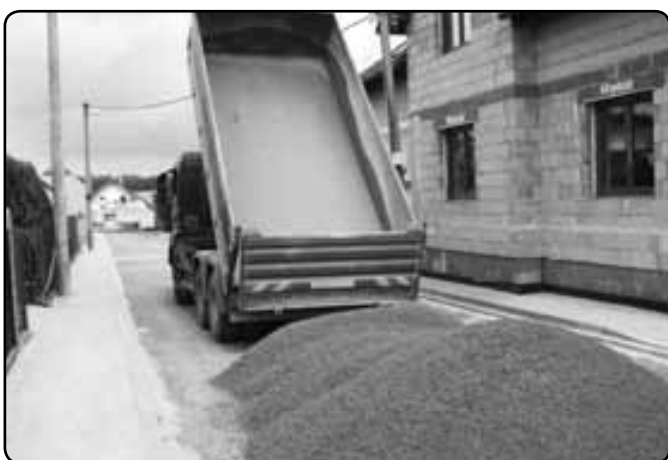
Navážení podkladových vrstev (srpen 2010)
