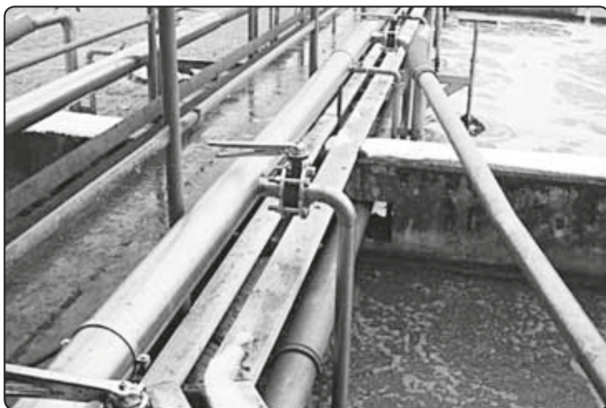
Líňská čistírna odpadních vod prochází úpravami
