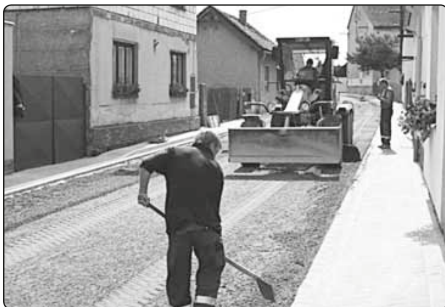
Stavební práce v Luční ulici
