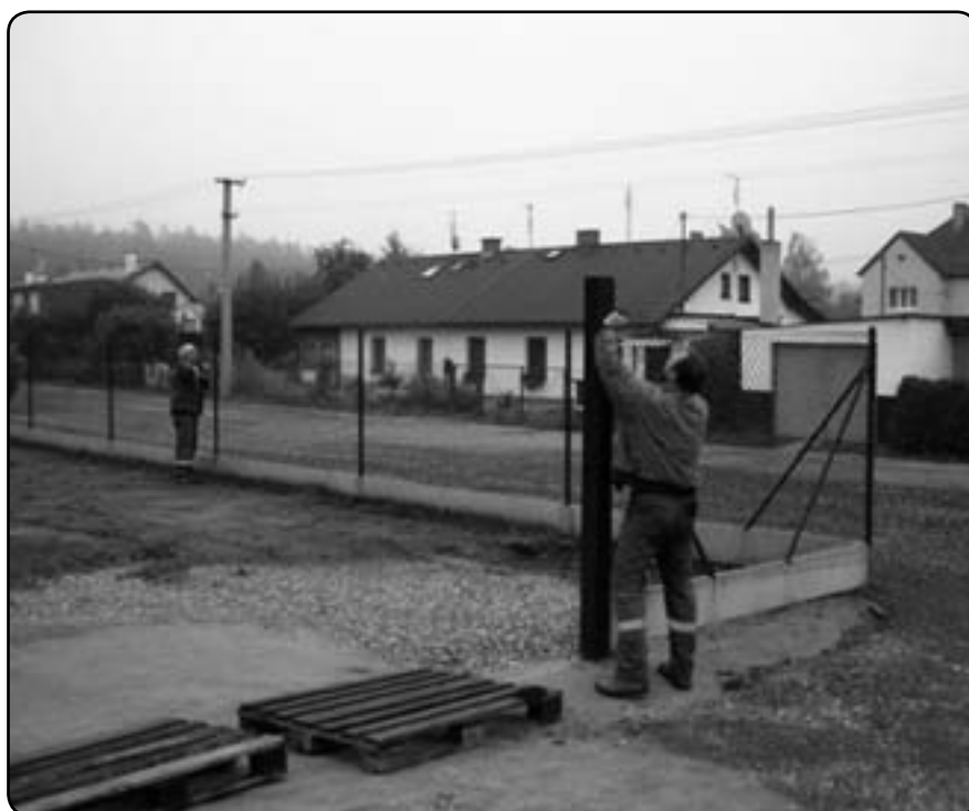
Výstavba nového oplocení (srpen 2011)
