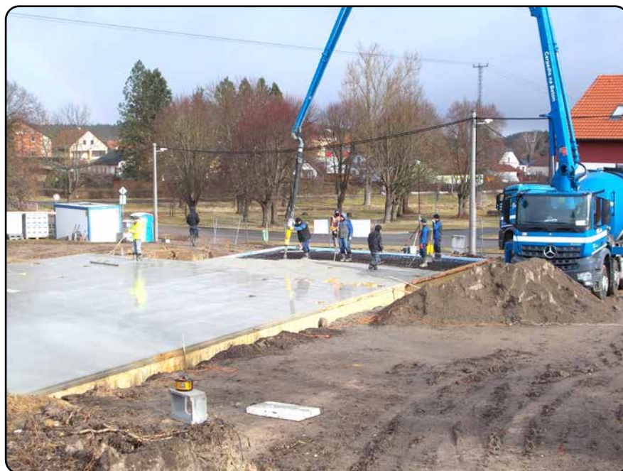
Betonování základové desky novostavby mateřské školy
