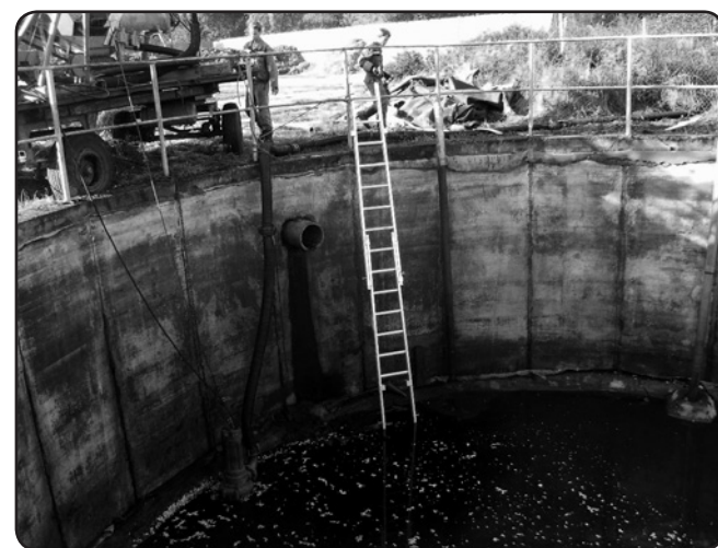
Čištění záchytné jímky
