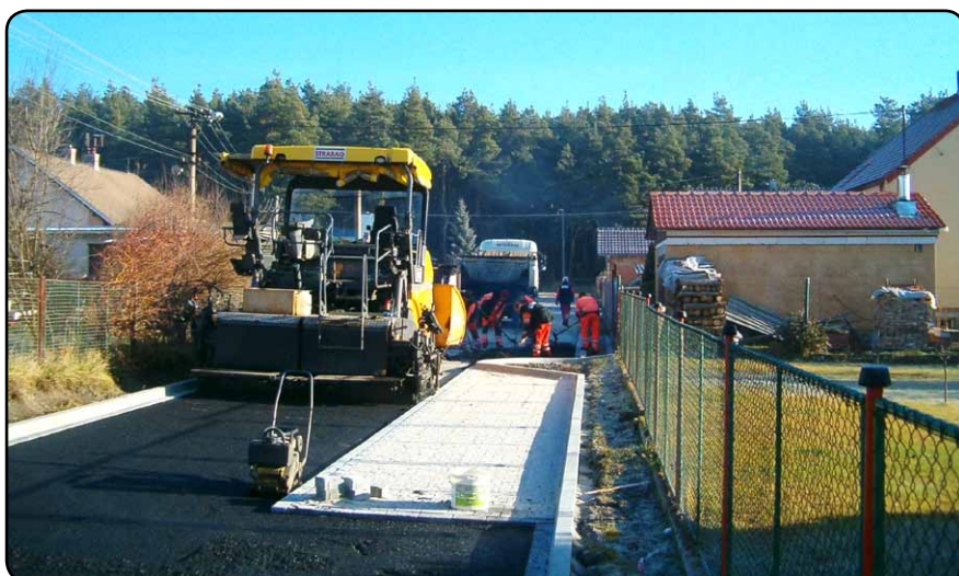
Pokládání asfaltového povrchu v ulici V Zahradkách krátce před vánočními svátky.
