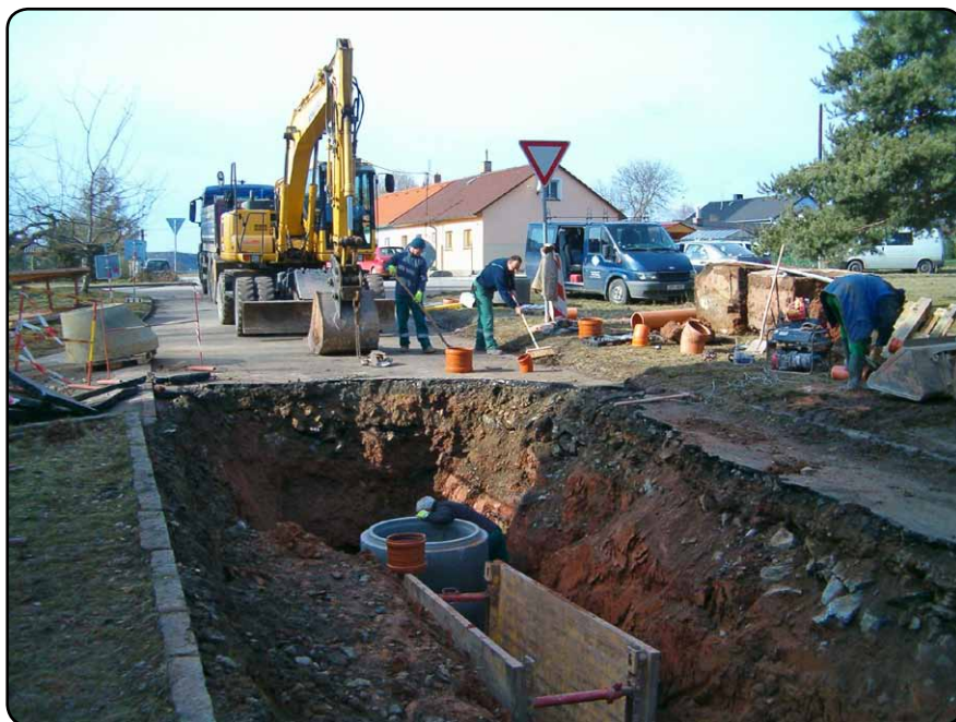
Posledním úsekem opravované kanalizace byla šachta před domem č.p. 429 a 430.
