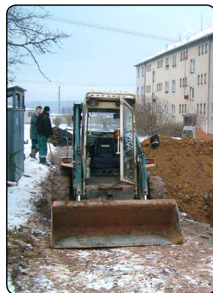
K opravě kanalizačního řádu v ulici U Kotelny bylo nutno vyhloubit místy až 3 m hluboký výkop.
