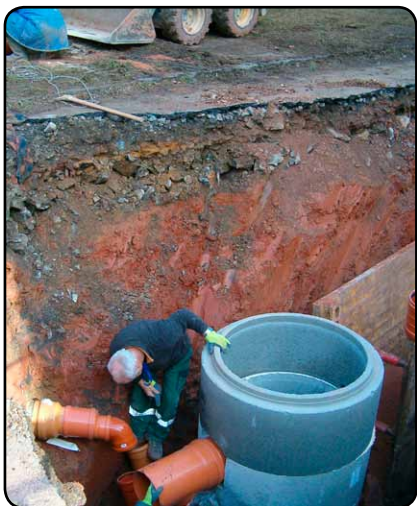
K novému kanalizačnímu potrubí byly přepojeny také kanalizační přípojky všech přilehlých bytových domů.
