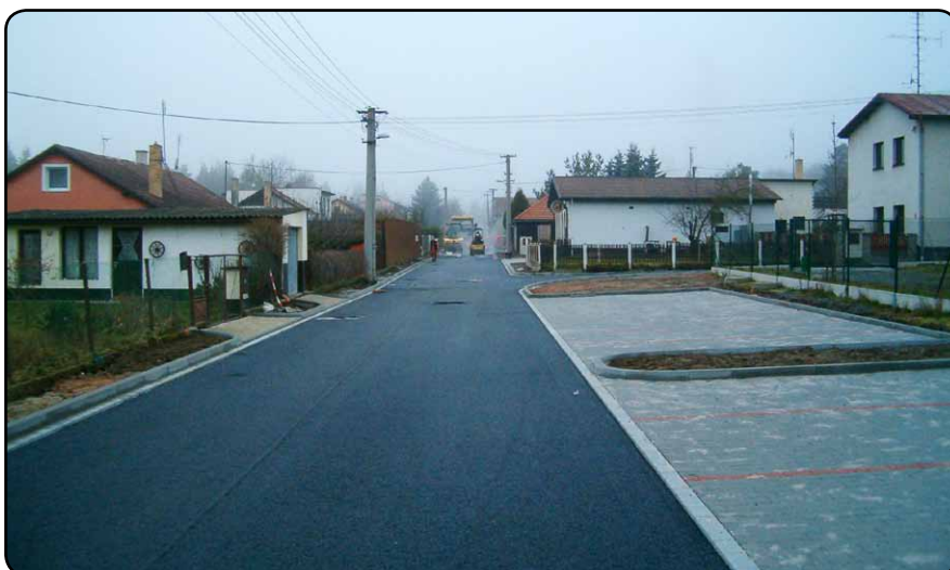
Obytná zóna v ulici V Zahradkách bezprostředně po svém dokončení.
