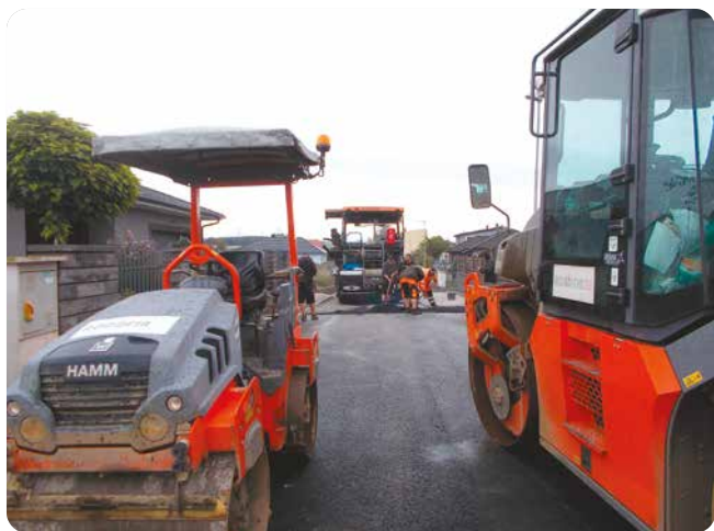
Pokládka asfaltu proběhla 1. srpna.
