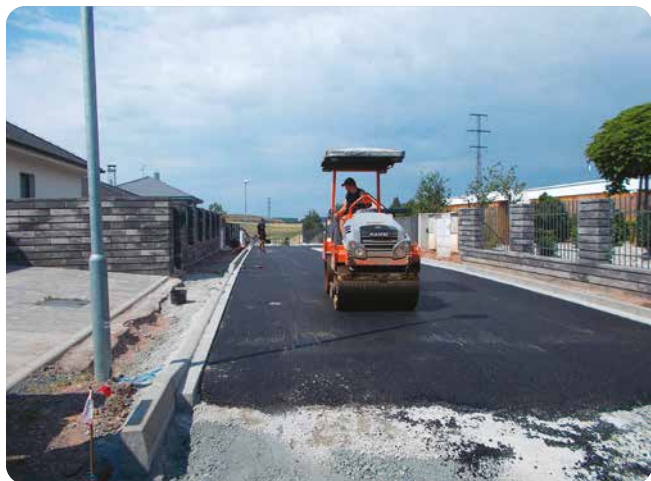
Pokládka spodní asfaltové vrstvy v jednom z dokončených úseků.
