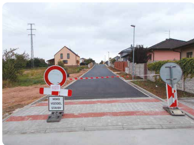
Západní vjezdový práh obytné zóny Ke Křížku.
