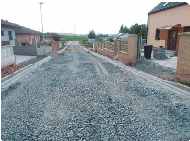
Rozestavěná komunikace po osazení betonových obrub.
