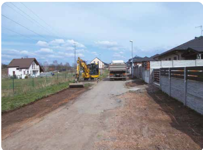
Zahájení prací v ulici Ke Křížku v dubnu 2025.
