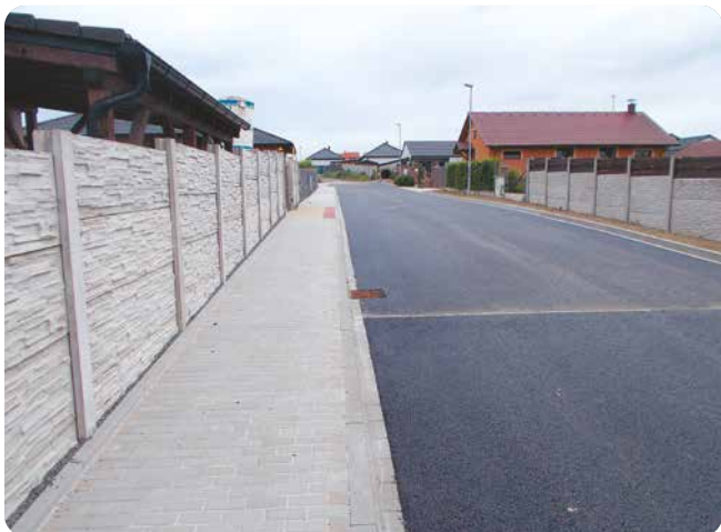
Dokončený úsek navazující obslužné komunikace K Okružince.
