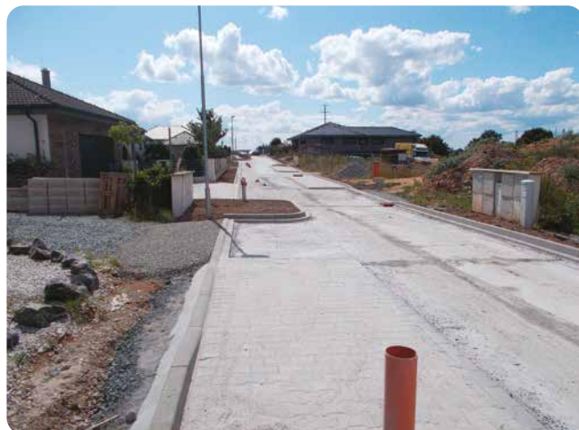
Na konci července již bylo vše připravené k závěrečnému asfaltování.
