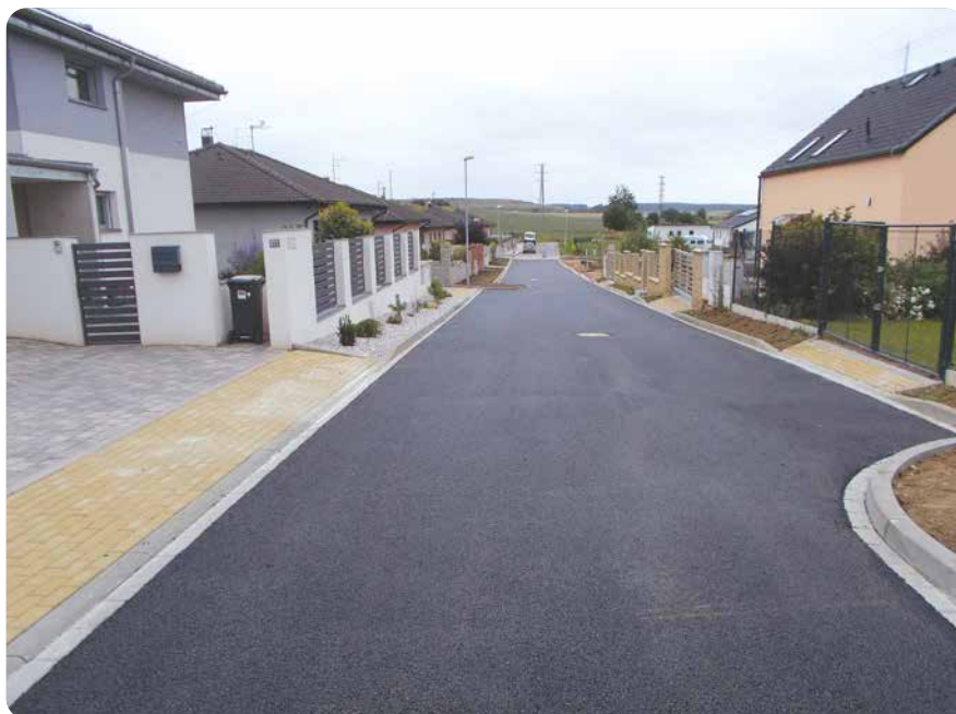
Dokončená ulice Ke Křížku na začátku srpna 2025
