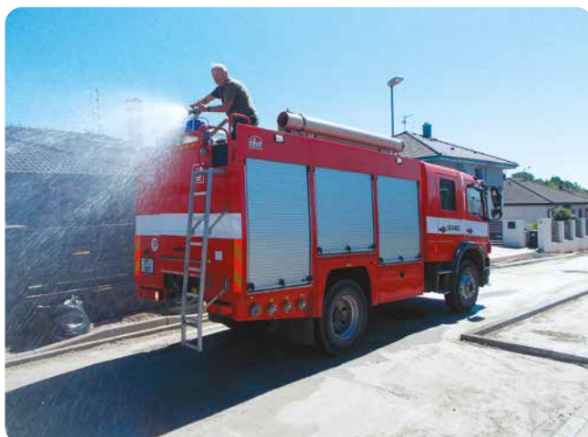
Kropení betonové stabilizace v horkém počasí zajistili místní hasiči.
