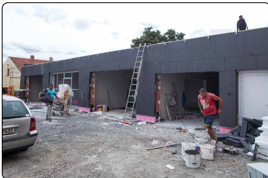
Stavba dílen údržby obce
