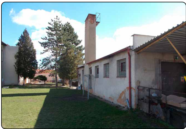
Místo stavby nové školní budovy
