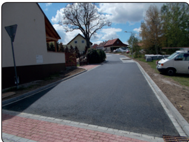
Dolní část ulice Na Svahu po rekonstrukci
