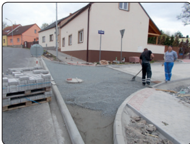
Práce na vjezdovém prahu do obytné zóny z Dobřanské ulice
