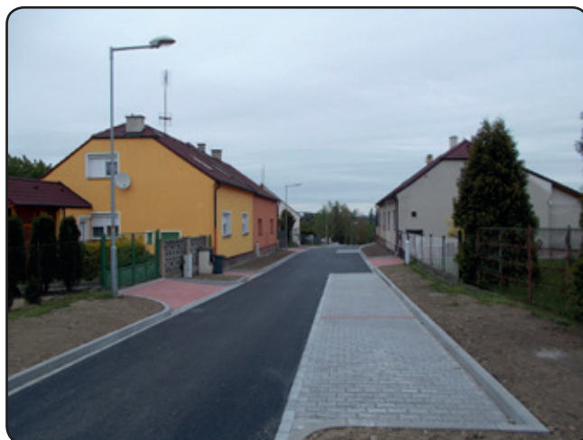
Horní část ulice Na Svahu po dokončení prací
