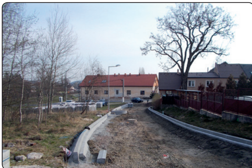
Osazování silničních obrub na počátku dubna
