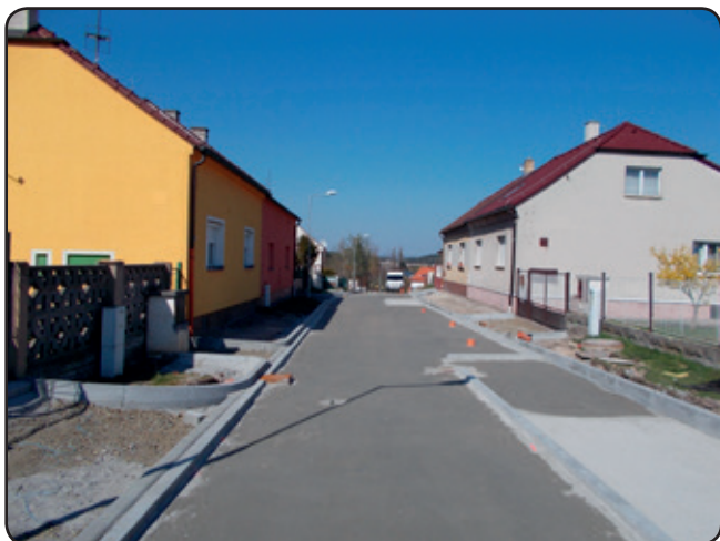
Betonová stabilizační vrstva
