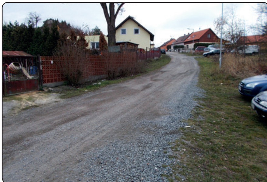
Ulice na Svahu před rekonstrukcí
