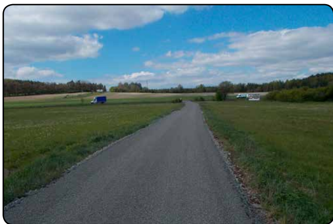
Nová komunikace u výjezdu na silnici Plzeň-Domažlice.
