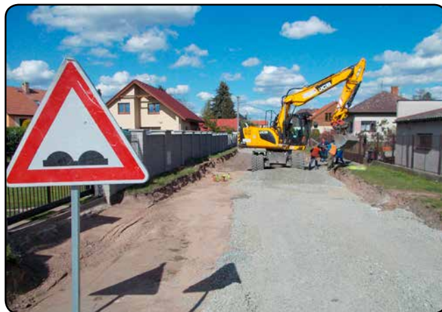
Terénní úpravy v Tiché ulici.
