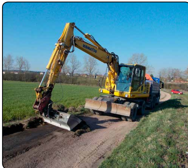
Zemní práce na původní polní cestě.
