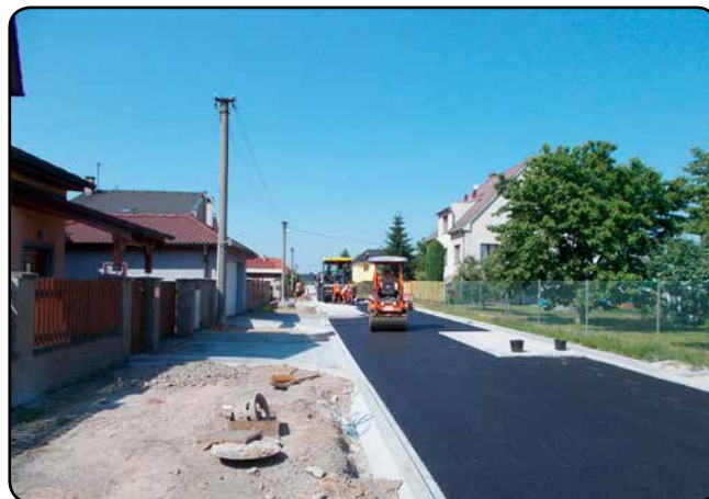
Asfaltování v Tiché.
