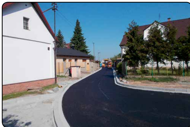
Nově vyasfaltovaný úsek v Rybářské ulici
