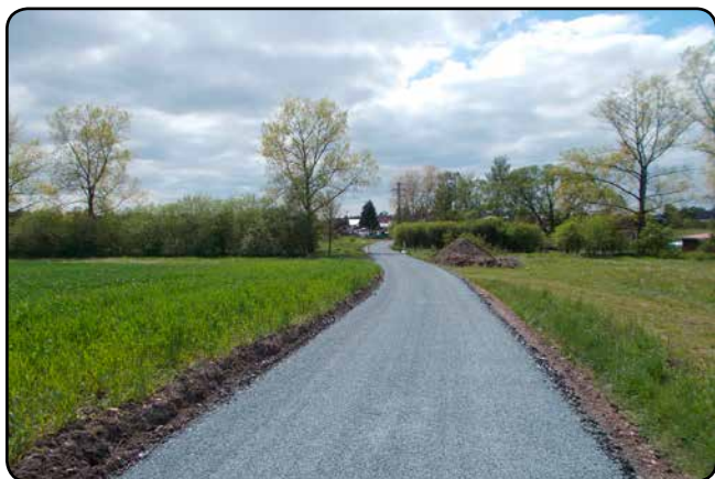
Úsek zrekonstruované polní cesty navazující na Plovární ulici.
