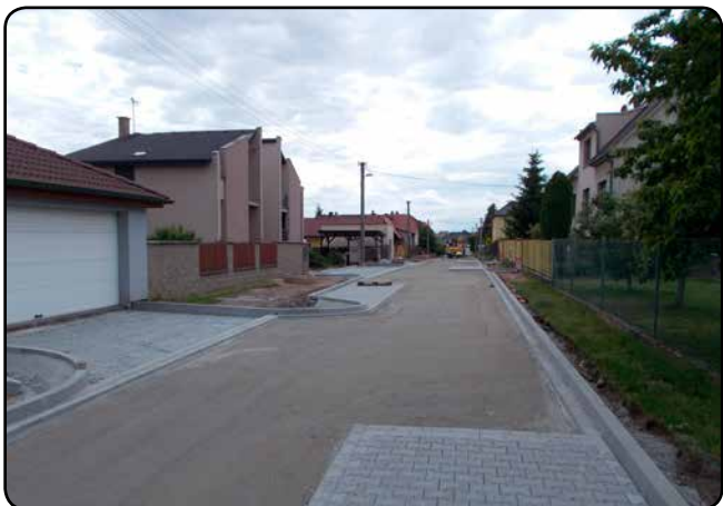
Nové obruby, stabilizační vrstva a vydlážděná parkovací stání.
