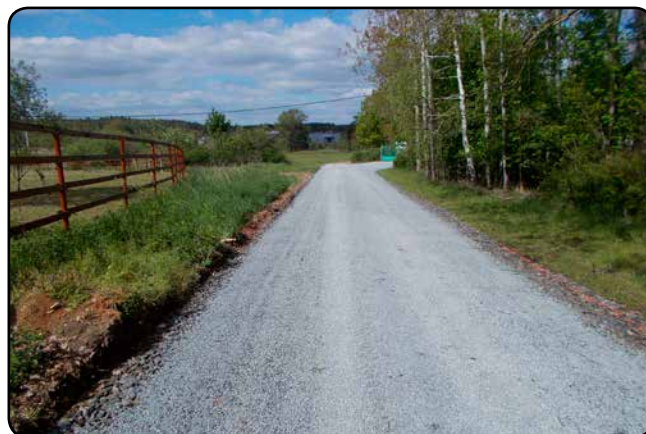
Nově upravený příjezd ke koupališti.
