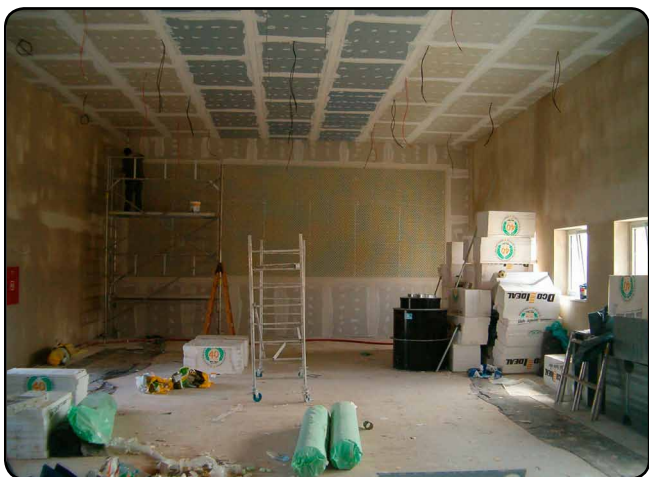
Práce v interiéru nového sálu (konec března 2015)
