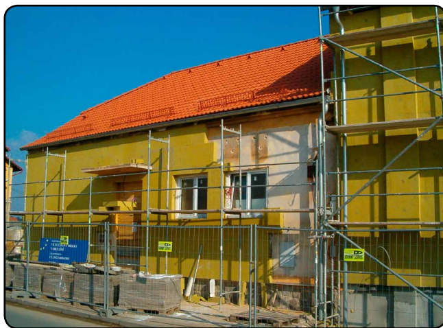
Zateplování budovy v únoru 2015
