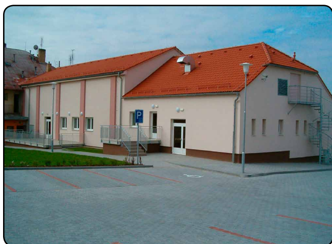
Nově vybudované parkovací plochy (konec dubna 2015)
