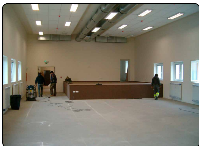
Sál s dokončeným pódium na konci dubna 2015
