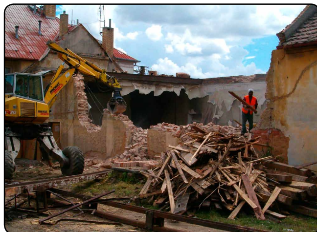
Demoliční práce v červenci 2014
