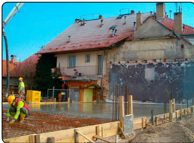
Betonování nové základové desky v říjnu 2014
