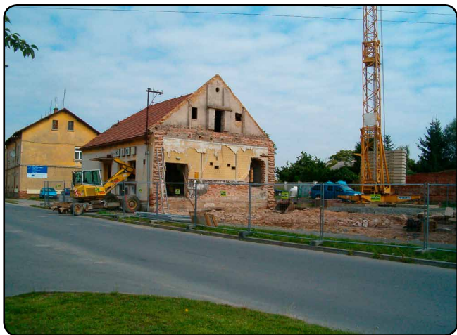
Stav po demolici bývalého kinosálu v srpnu 2014
