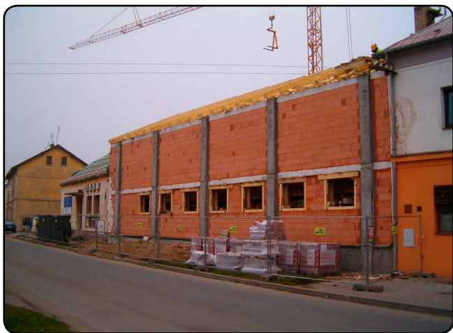
Stav prací v prosinci 2014
