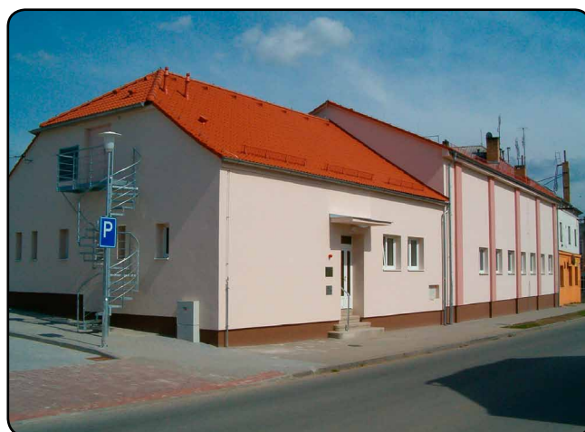
Dvůr víceúčelový objektu po dokončení stavebních prací (květen 2015)
