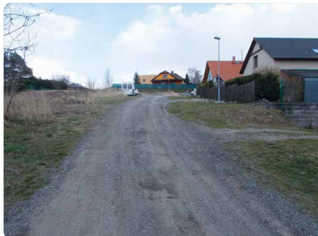
Jsou místní komunikace, které na rekonstrukci čekají – například ulice Na Podkově.
