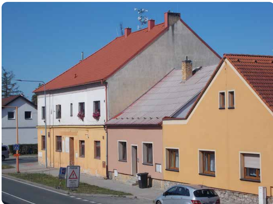
Restaurace Brusel má zatím novou střechu, pokračování rekonstrukce se připravuje.
