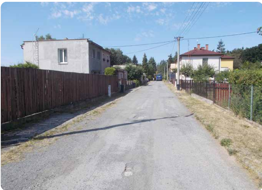
Na Sulkově jsou v nejhorším stavu ulice V Zahrádkách (západní část) a Línská.
