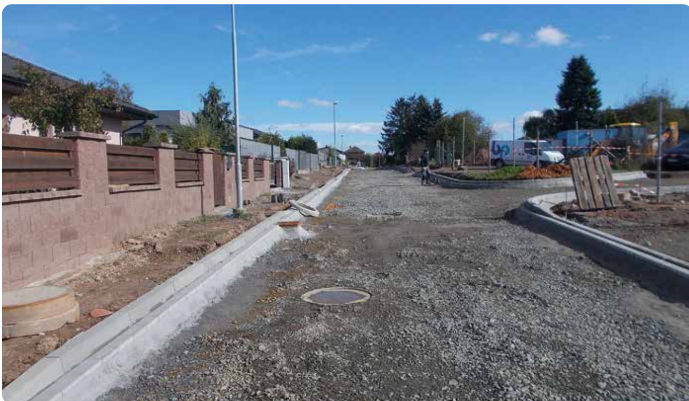
Nové osazené obruby u křižovatky s Rybářskou ulicí.
