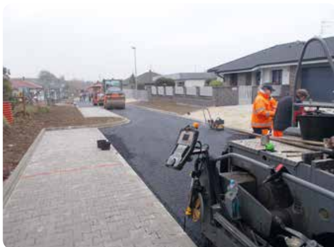
Pokládka spodní asfaltové vrstvy.
