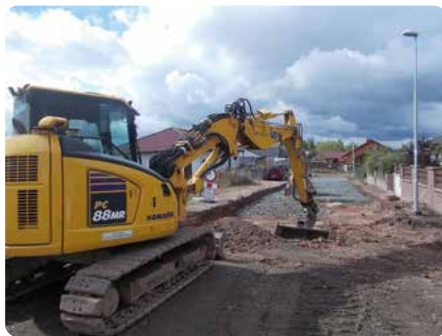
Zahájení stavebních prací počátkem září 2024.
