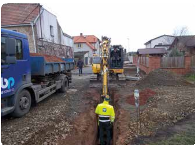
Zemní práce na přípojce k dešťové vpusti.
