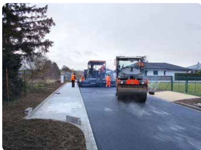
Závěrečné asfaltování.
