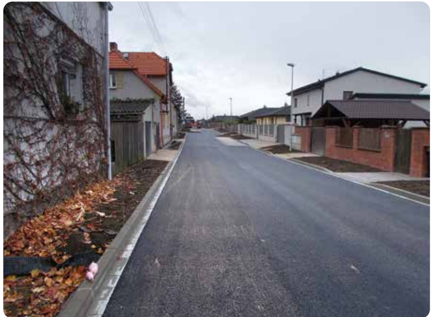
Vyasfaltovaný prostřední úsek nové komunikace.
