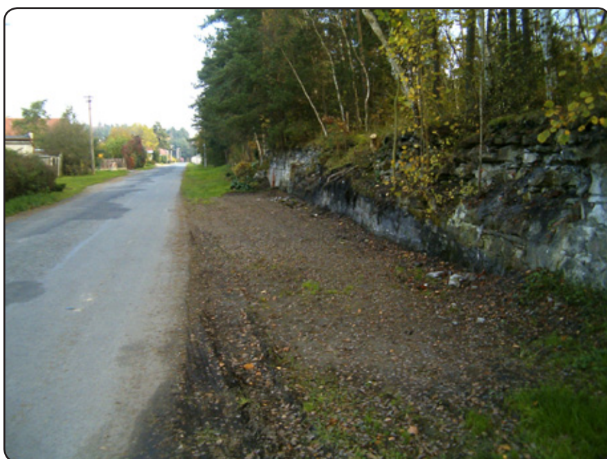
Terénní úpravy byly provedeny v ulici Na Perkách na Sulkově. Zkulturněno bylo prostranství mezi vozovkou a bývalou důlní rampou, navazující na nové stanoviště kontejnerů na tříděný odpad.
