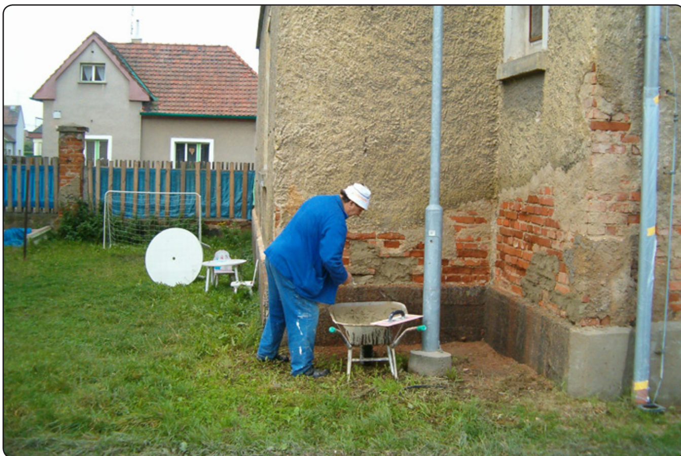
Zahájeny byly opravy fasád v hornické kolonii. Konkrétně se jedná o opravu spodních částí fasád všech sedmi obytných domů. Práce na třech domech prováděli zaměstnanci obce, na zbývajících domech pracovali najatí zedníci. Náklady byly hrazeny z prostředků bytového hospodářství obce, tzn. z prostředků vybraných na nájemném.
