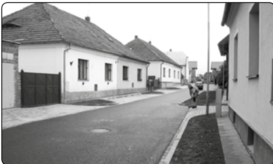
Dokončovací práce v Chodské ulici v červnu 2012
