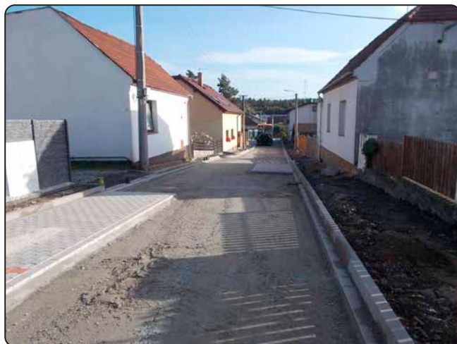
Ulice po dokončení dlažeb a položení betonové stabilizační vrstvy
