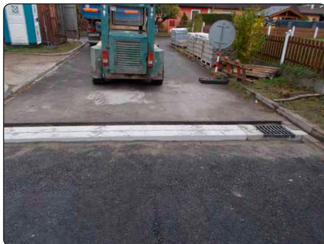
Vpust' na dešťovou vodu na jižním konci ulice
