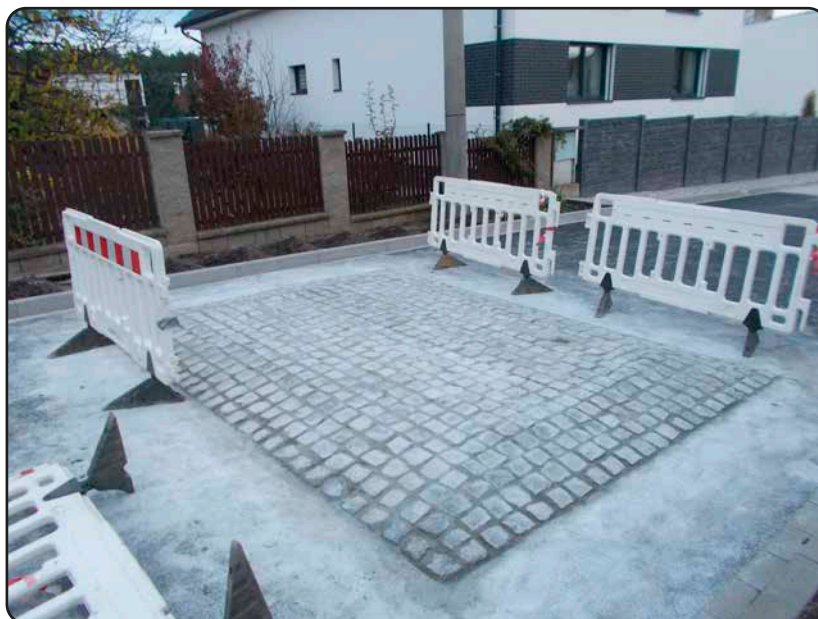
Zpomalovací práh bezprostředně po dokončení
