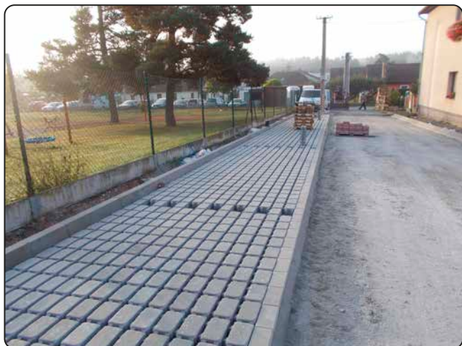
Pokládka dlažby na parkovacích místech u dětského hřiště
