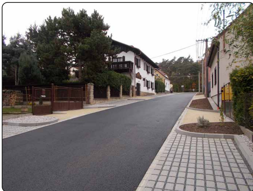
Nově osazené betonové obruby
