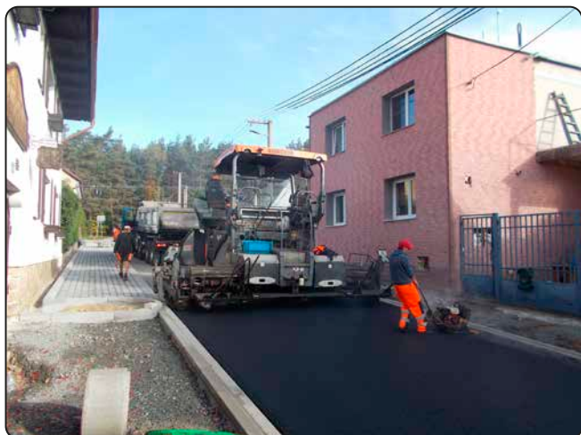
Pokládka spodní asfaltové vrstvy
