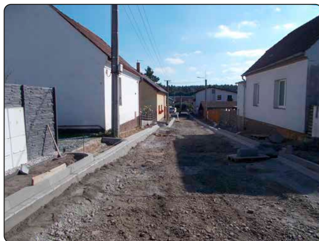
Nově osazené betonové obruby
