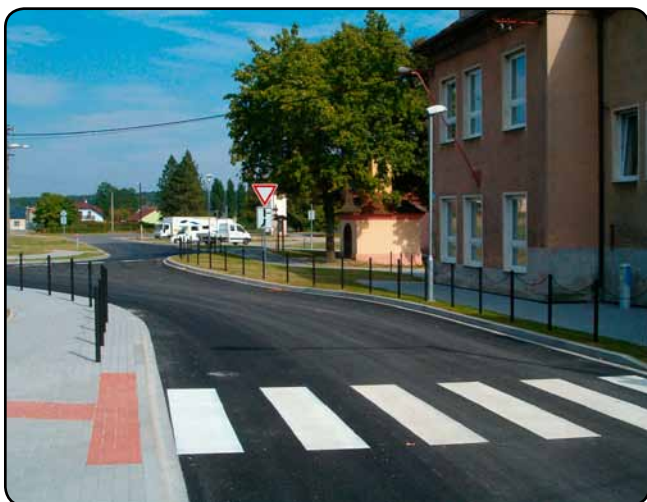
Nové dopravní řešení u základní školy I. stupně
