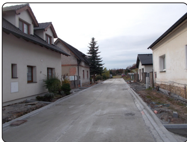
Čerstvě položená stabilizační vrstva
