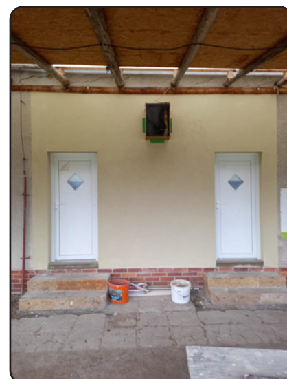
Rekonstrukce sociálního zařízení
