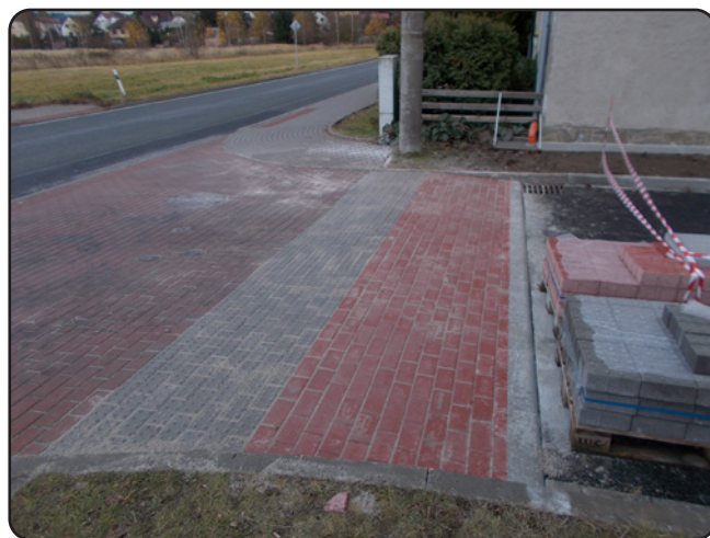
Úprava vjezdového prahu do obytné zóny
