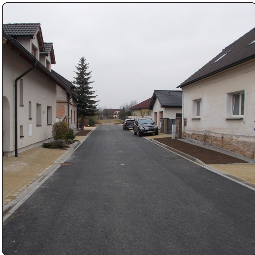
Dokončená komunikace v listopadu 2021
