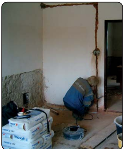
Součástí rekonstrukce byla také výměna nevyhovující elektroinstalace
