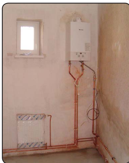
V prostorách knihovny instalatérská firma osadila nový plynový kotel
