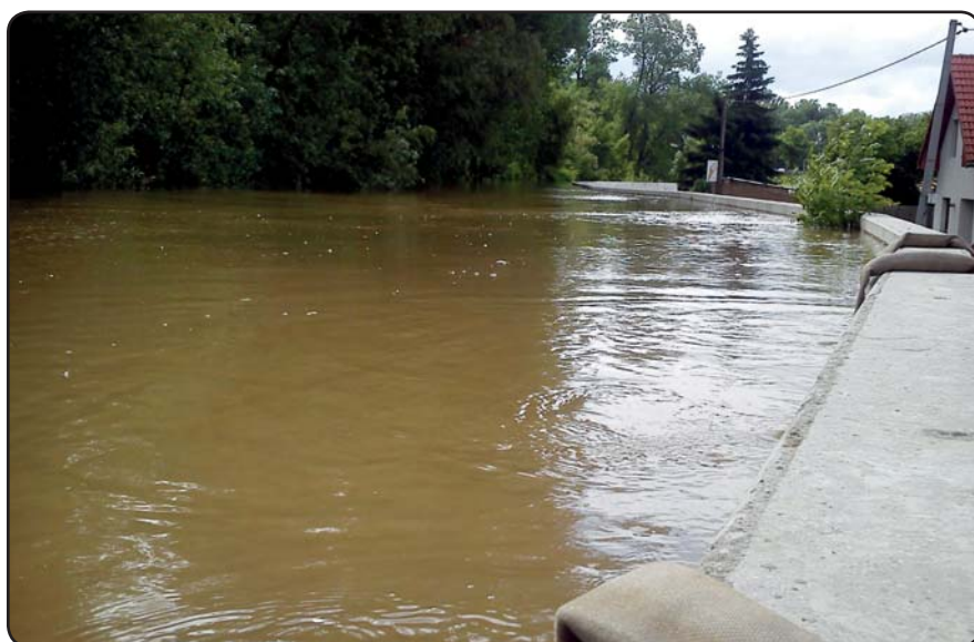
Hořín 4. 6. 2013 – poslední okamžiky před přetečením protipovodňové hráze
