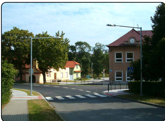
Nově upravená křižovatka u kapličky (konec srpna 2015)
