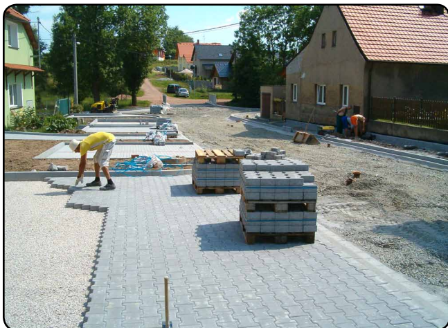
Pokládání zámkové dlažby (začátek července 2015)
