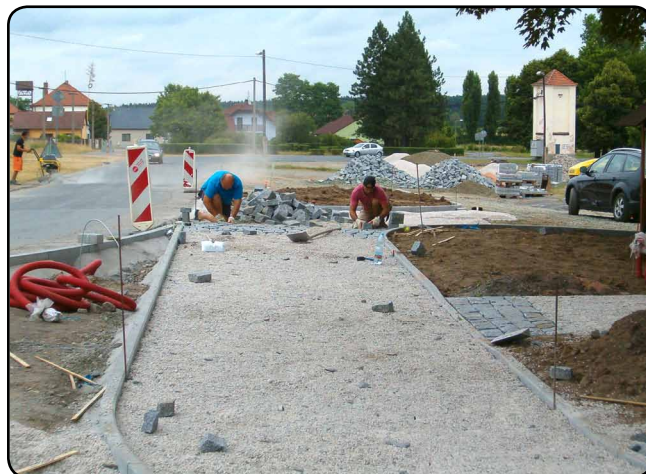
Pokládání žulové dlažby (červenec 2015)
