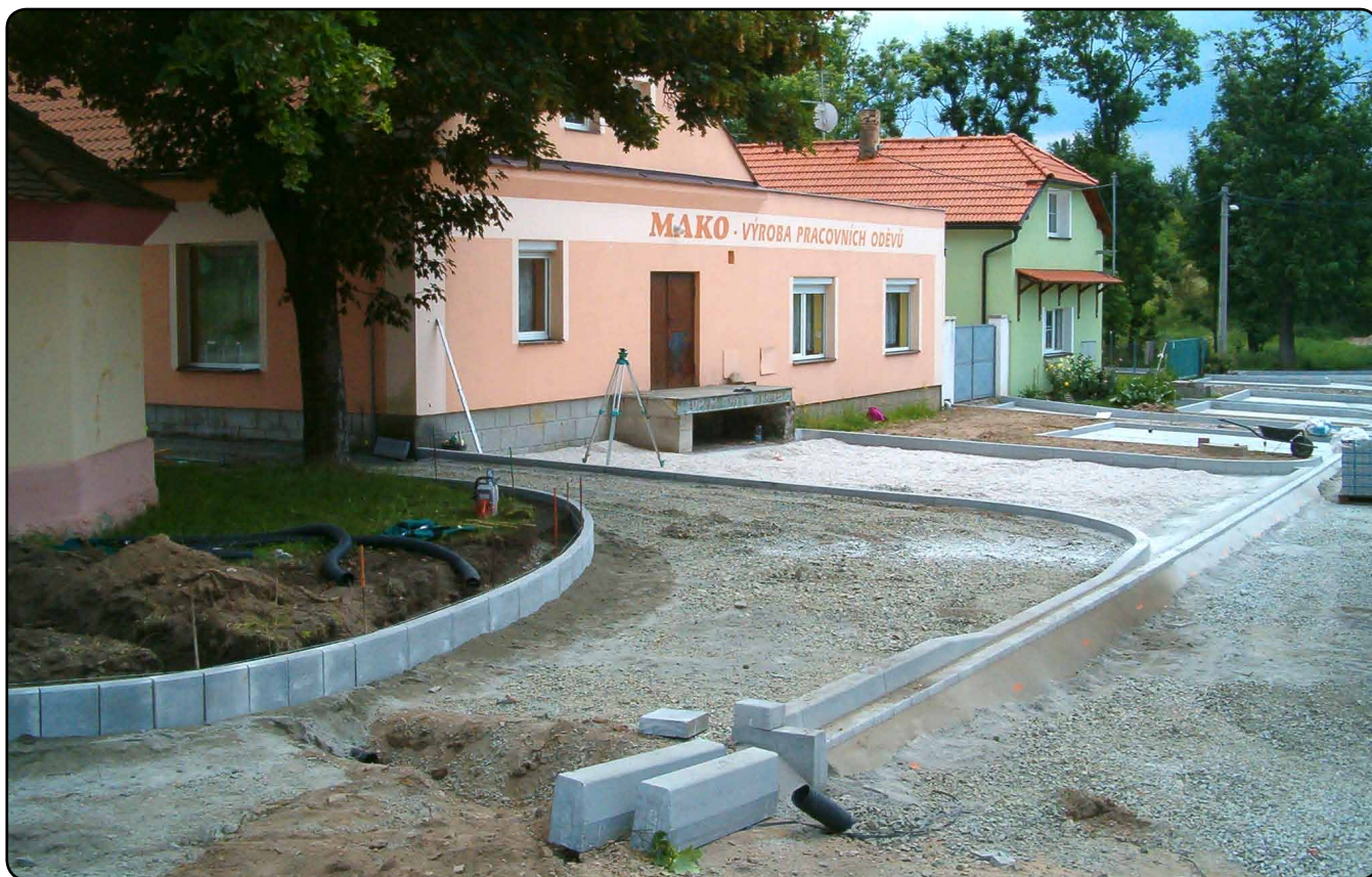
Osazování obrub u kapličky (konec června 2015)
