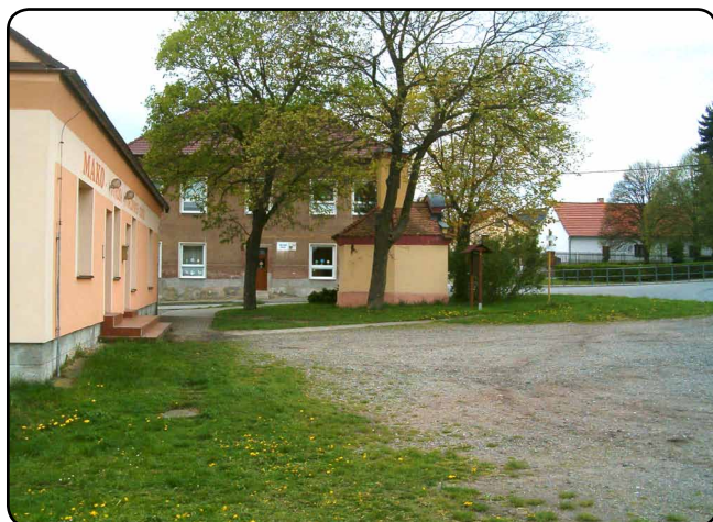
Prostor u kapličky před zahájením prací (duben 2015)
