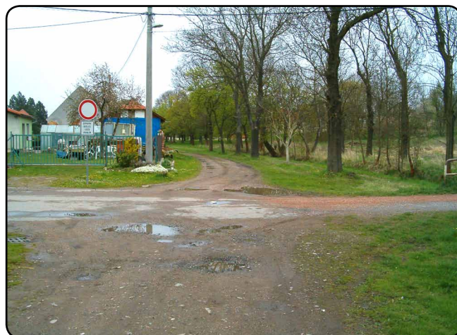
Křižovatka u Zálužského potoka před rekonstrukcí (duben 2015)
