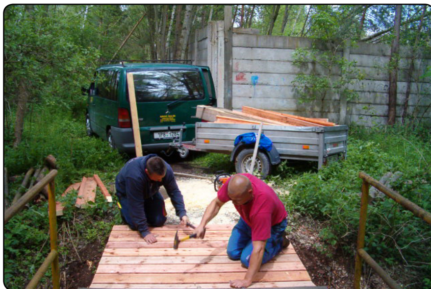
Jednoduchá oprava lávky u čerpací stanice na Sulkově.
