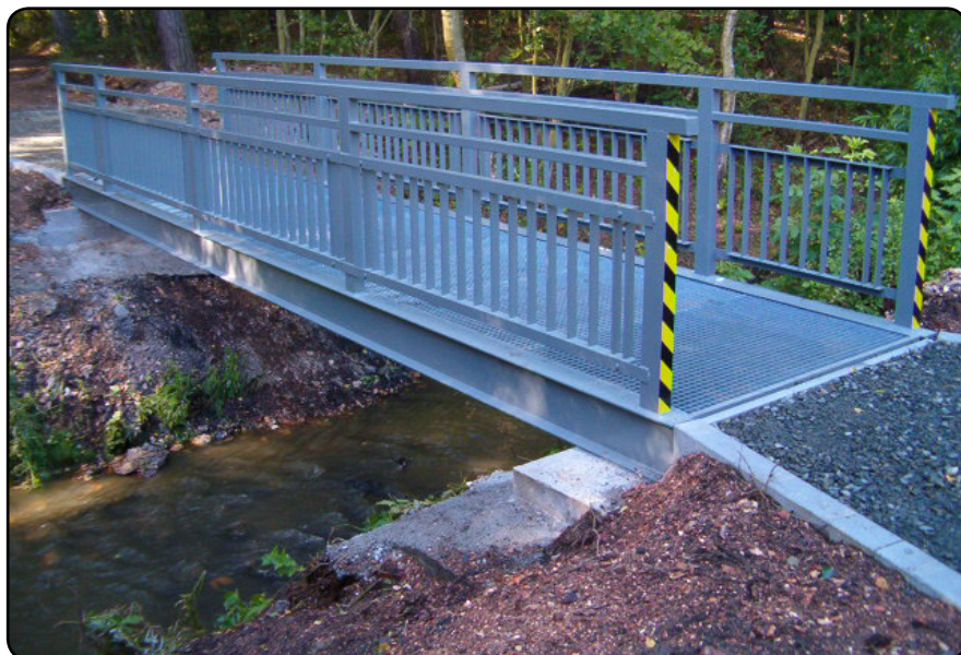
Lávka přes Luční potok u závodu Gühring.
