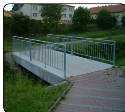
Opravená lávka pro pěší u Návesního rybníka v Líních.
