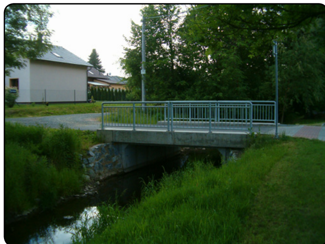
Zrekonstruovaný silniční most přes Zálužský potok.
