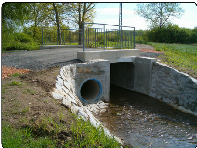
Nově zrekonstruovaný most v Plovární ulici.
