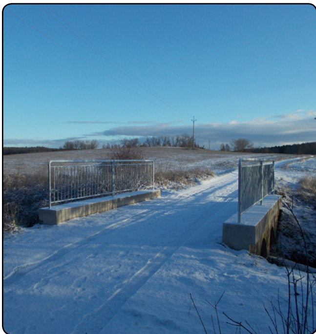
Opravený můstek s novým zábradlím na cestě ke koupališti
