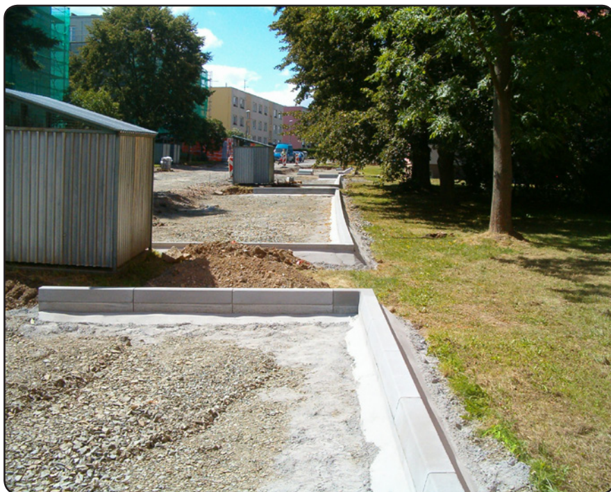
Aktuální stavební práce ve Vodárenské ulici (2016)
