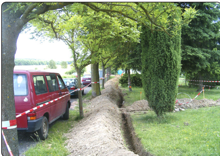
Rekonstrukce rozvodů nízkého napětí (2014)
