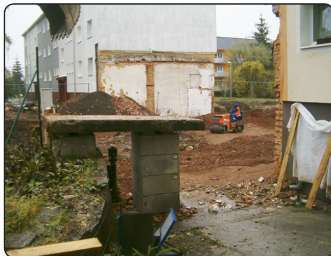
Demolice bývalé centrální kotelny (2015)
