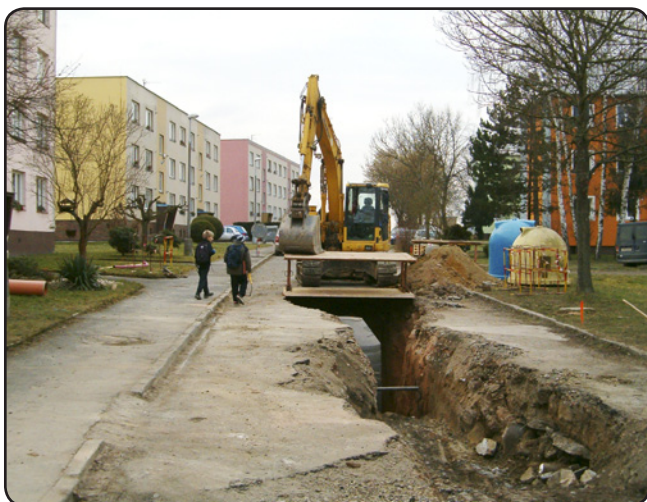
Rekonstrukce kanalizace ve Vodárenské ulici (2015)
