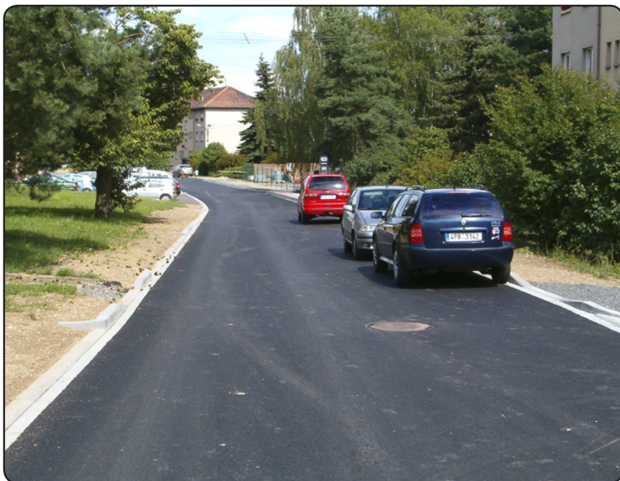
Nová vozovka v ulici U Kotelny (2014)
