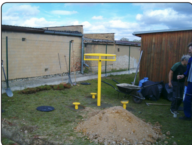
Instalace trojité „točny“ na dětském hřišti na sídlišti
