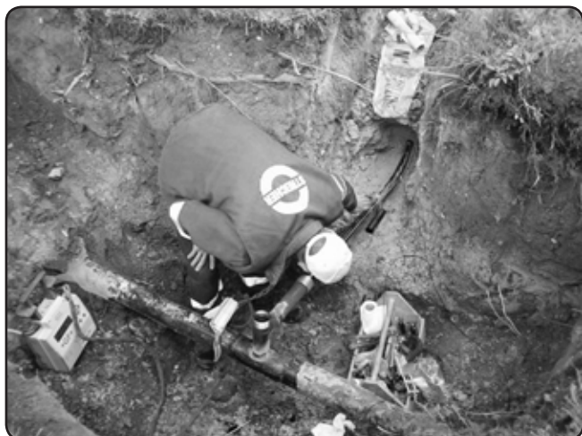
Bylo vybudováno 633 m středotlakého plynovodu a 16 přípojek k bytovým domům o celkové délce 116 m
