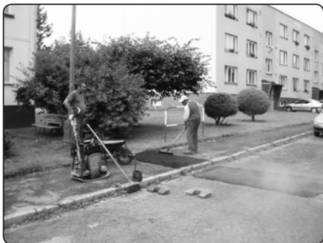
Začátkem července byly opraveny povrchy v místech překopů
