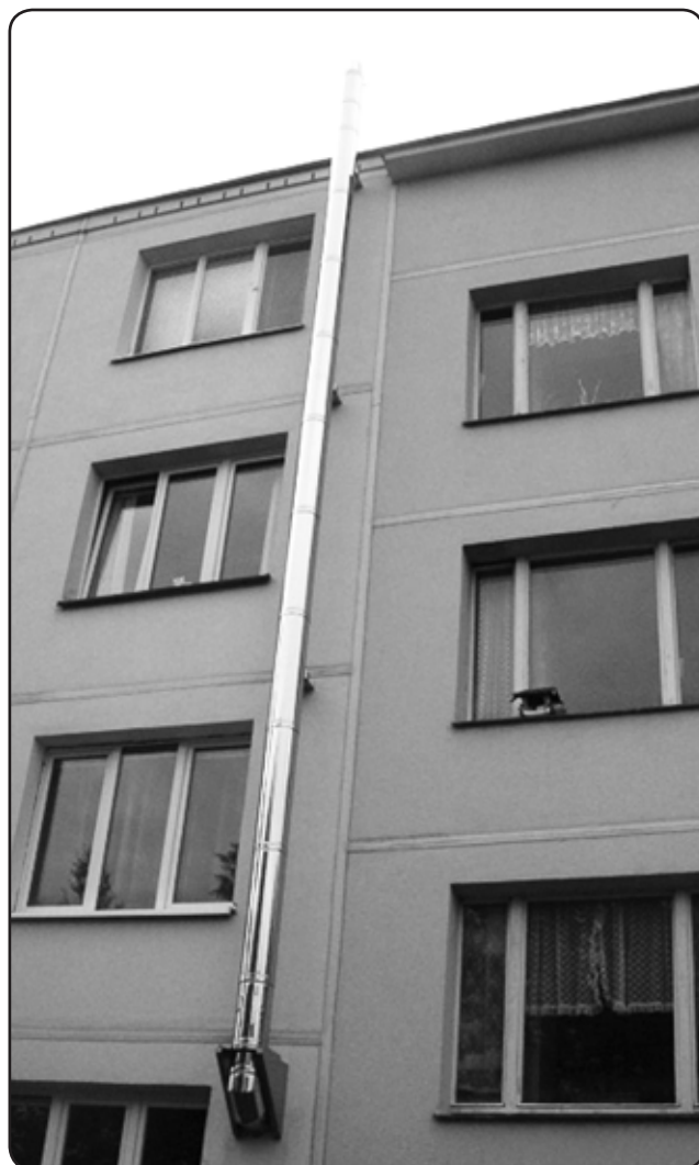
Také na jednotlivých domech bylo možno zaznamenat známky stavební aktivity.
