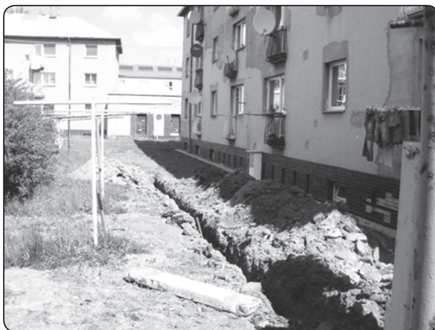
Po vytýčení podzemních sítí následovaly zemní práce a instalace sloupků pro hlavní úzávěry plynu
