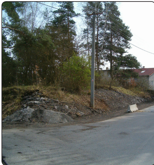
V ulici Na Šachtě bylo odstraněno křoví, které bránilo řidičům ve výhledu a snižovalo bezpečnost silničního provozu.
