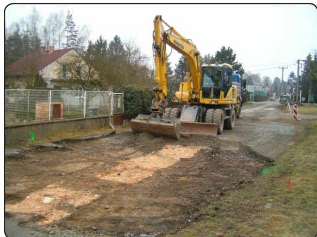
Zahájení nových stavebních prací na 2. části projektu (únor 2014)
