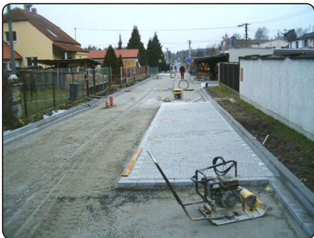
Dláždění parkovacích stání (prosinec 2013)
