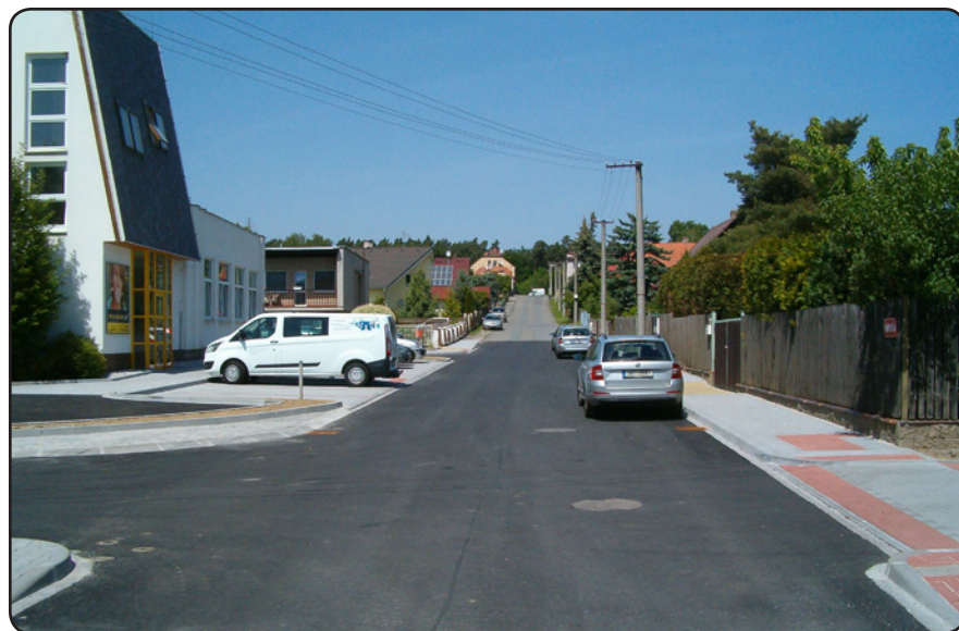
Zrekonstruovaný úsek Pionýrské ulice pře sídlem společnosti Schneider Bohemia (květen 2014)
