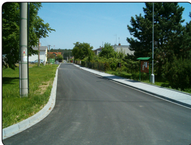
Dokončená obslužná komunikace pod restaurací Sparta (květen 2014)
