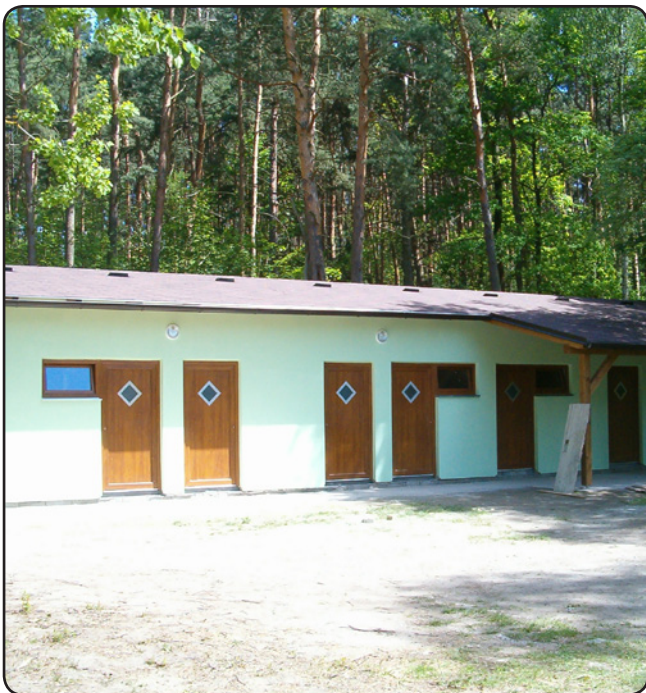
Sportovní areál s vodní nádrží je připraven na letní sezónu. Rekonstrukci objektu občerstvení a sociálních zařízení zajistila obec prostřednictvím vlastních zaměstnanců, tesařské a pokrývačské práce provedl pan Tomáš Beran se svojí firmou, s vodoinstalátorskými pracemi pomohl pan Pavel Sekerka.
