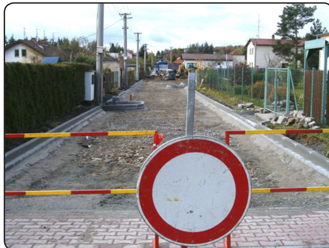
Betonování obrub (listopad 2013)
