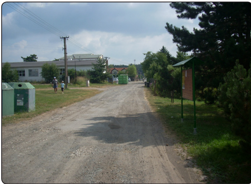
Ulice V Zahrádkách před zahájením rekonstrukce (červenec 2013)
