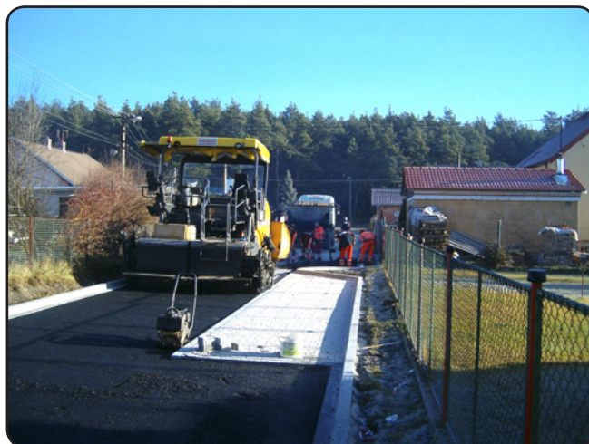
Asfaltování (polovina prosince 2013)
