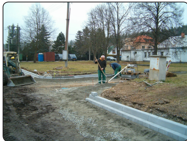
Betonování obrub ve sjezdu do areálu TJ Sparta Sulkov
