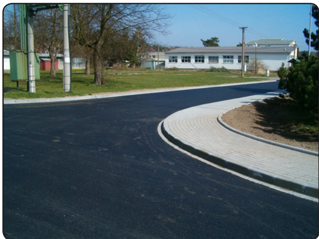
Nový chodník u křižovatky s ulicí Na Šachtě (duben 2014)
