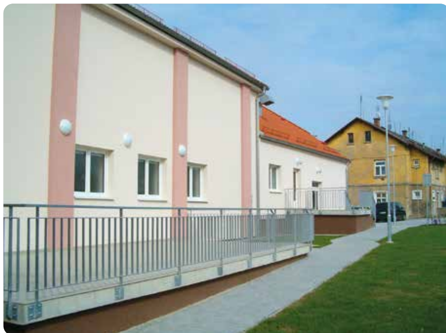
Nově dokončený Obecní dům (srpen 2015).
