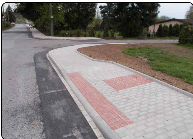
Dokončená úprava odbočky do ulice U Vodárny
