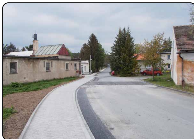
Celkový pohled na dokončený chodník
