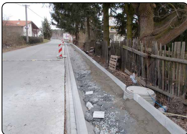
Osazování betonových obrub
