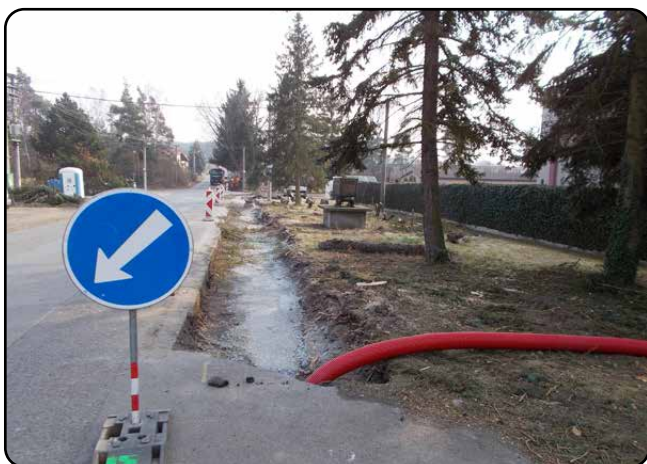
Zemní práce a pokládka chráničky pro kabel vysokého napětí
