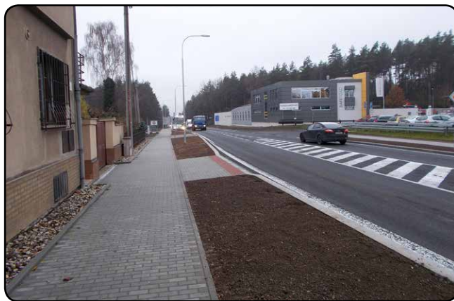
Průtah Sulkovem po dokončení stavby v listopadu 2019
