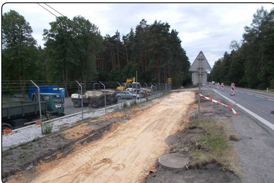
Zatrubnění nové dešťové kanalizace a zpevnění svažitého terénu
