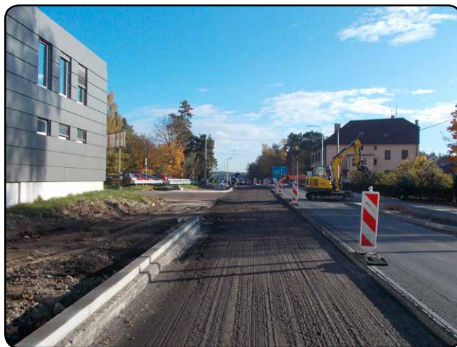
Vyfrézovaný jízdní pruh před pokládkou asfaltových vrstev
