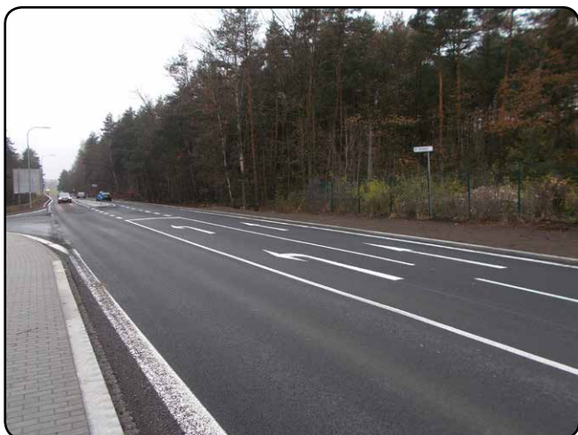
Odbočovací pruh do ulice Na Šachtě
