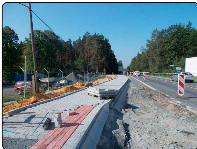
Stavba chodníku k autobusové zastávce ve směru na Plzeň
