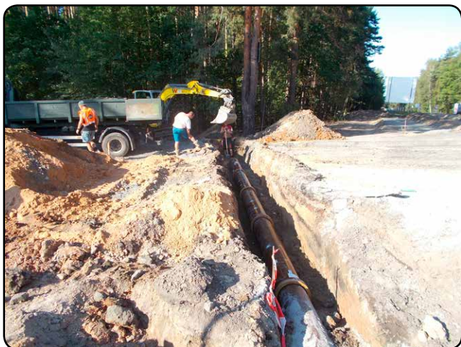
Dešťová kanalizace na křižovatce s ulicí Na Šachtě
