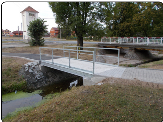
Nová lávka přes Zálužský potok na lířské návsi
