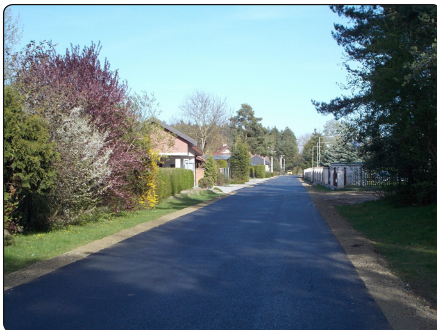
Dokončená ulice Na Perkách
