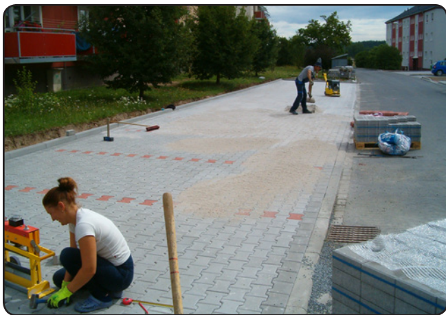
Dláždění parkovacích míst v ulici U Kotelny (červenec 2017)
