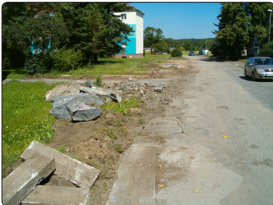
Zahájení stavebních úprav Vodárenské ulice (srpen 2016)
