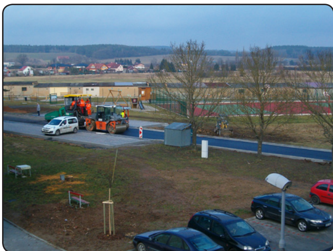
Asfaltování komunikace u víceúčelového sportoviště (prosinec 2016)
