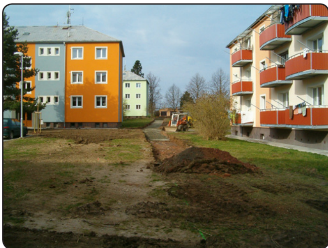
Budování nového chodníku (březen 2017)
