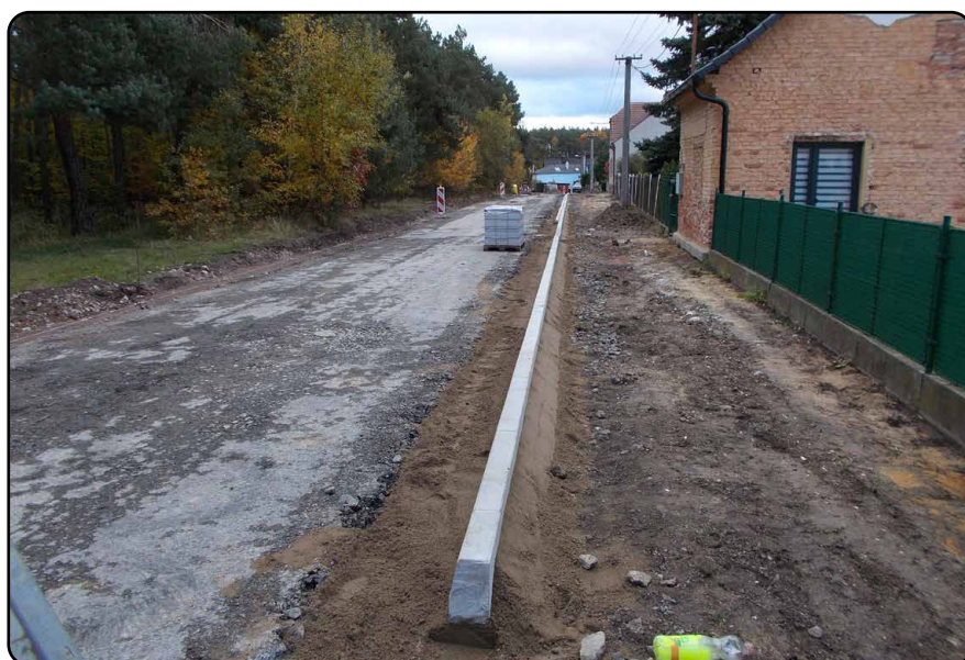
Osazování silničních obrub
