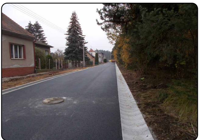
Čerstvě položená spodní asfaltová vrstva
