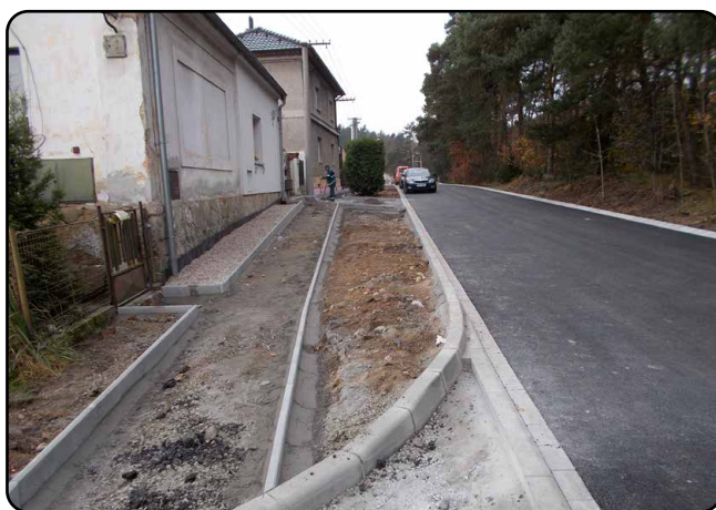
Svrchní asfaltová vrstva a příprava obruby připravené pro nový chodník
