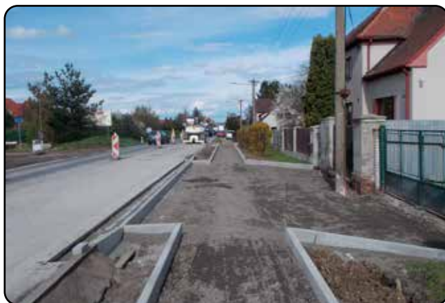
Výstavba nového úseku chodníku
