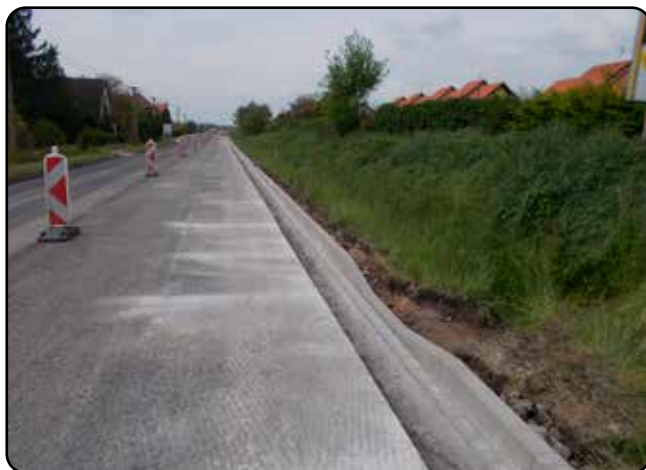
Nově osazené obrubníky na pravé straně silnice ve směru na Zbůch
