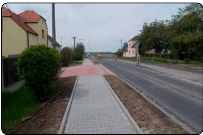
Dokončené prodloužení chodníku
