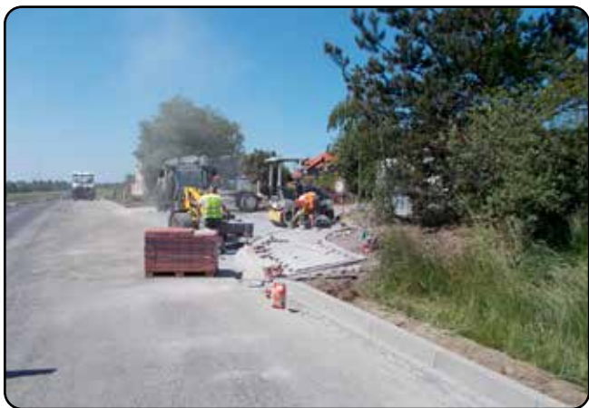
Práce na nové odbočce do ulice Na Dlouhých
