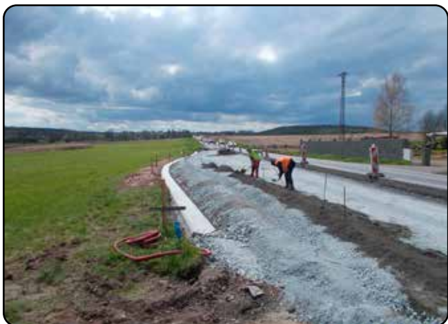
Stavební práce na intravilánové vjezdové bráně
