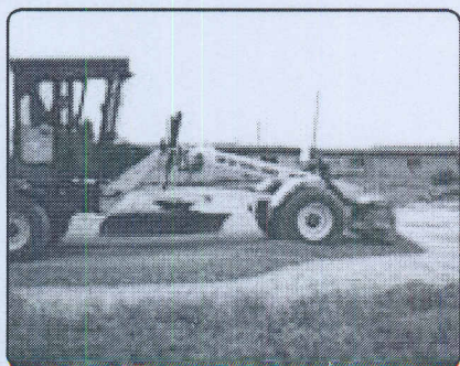
Pokládka podkladové štěrkové vrstvy (září 2009)
