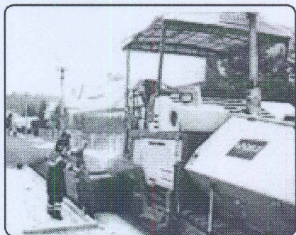
Pokládka spodní asfaltové vrstvy (prosinec 2009)
