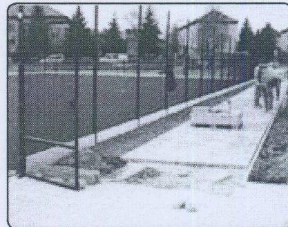
Výstavba přístupového chodníku ze zámkové dlažby (listopad 2009)
