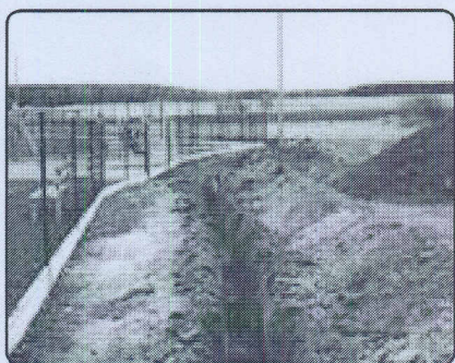
Výstavba veřejného osvětlení (prosinec 2009)
