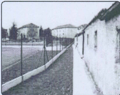
Vybudování betonového žlabu k odvodu dešťové vody z přilehlých řadových garáží (listopad 2009)
