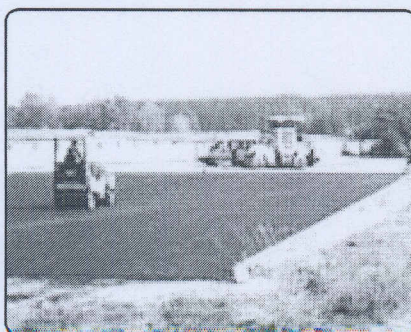
Pokládka drenážního asfaltu (září 2009)
