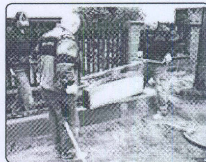
Osazování silničních obrub (prosinec 2009)
