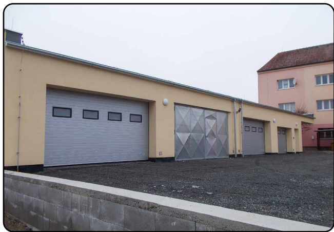
Nově dokončené dílny údržby obce
