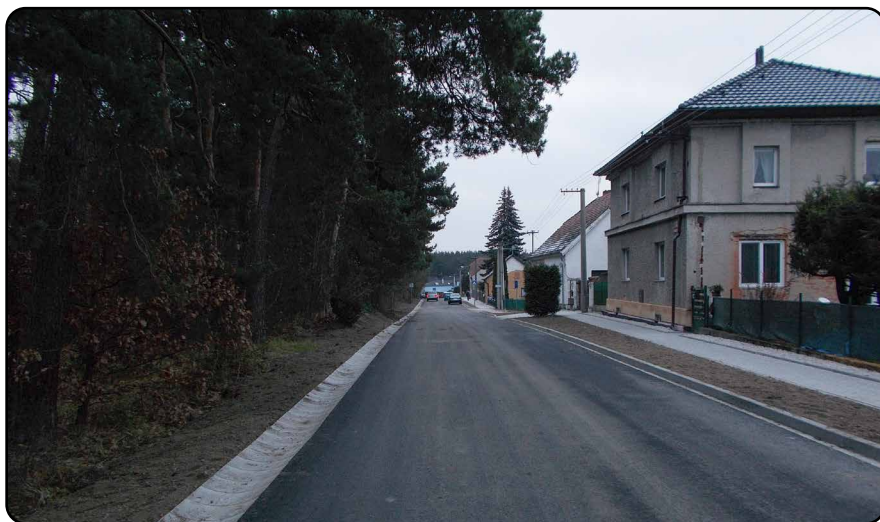
Opravená Polesní ulice
