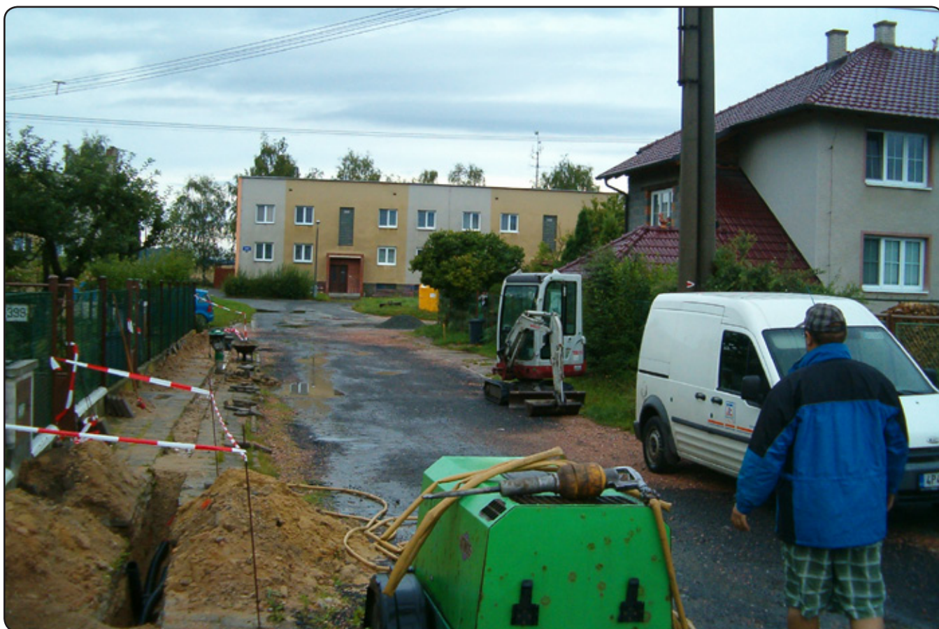
Rekonstrukce rozvodů nízkého napětí pokračuje. Ze sídliště se hlavní práce postupně přesunuly do ulic Lidická, Dobřanská, Na Svahu a U Rybníka.
