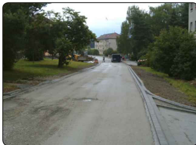
Ulice po položení stabilizační vrstvy
