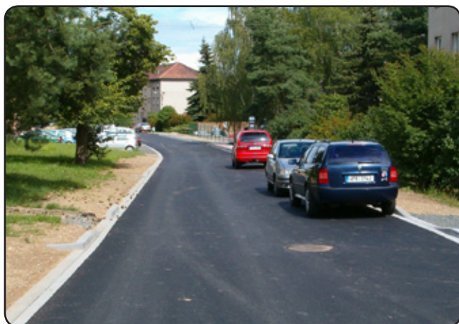
Ulice U Kotelny po dokončení stavebních prací
