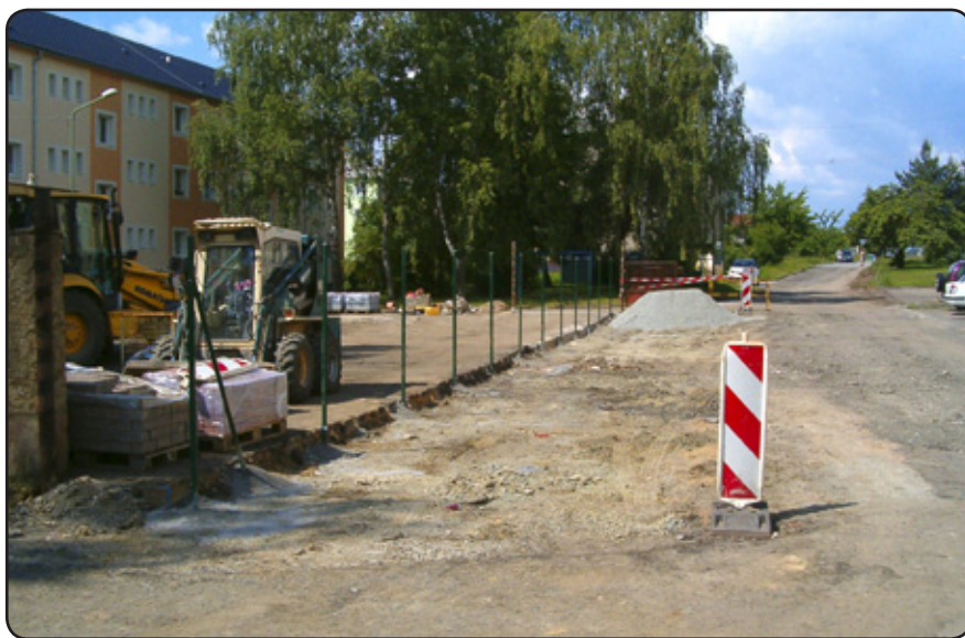
Úpravy ohrady před objektem bývalé kotelny
