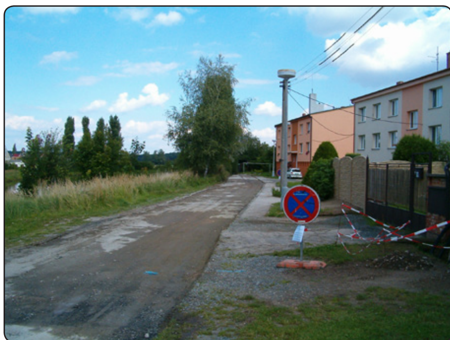
Oprava vozovky proběhla v ulici U Rybníka. Odfrézován byl polorozpadlý betonový povrch a na podklad byla následně položena jedna vrstva asfaltu. Opravu v hodnotě cca 250 tis. Kč uhradila obec z prostředků uspořené na zimní údržbě během prvních měsíců letošního roku.
