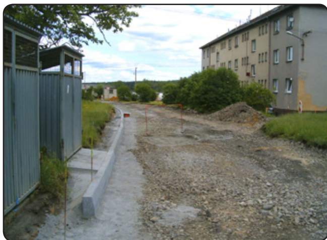
Zemní práce a osazování betonových obrub
