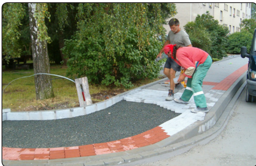
Dláždění chodníku u autobusové zastávky
