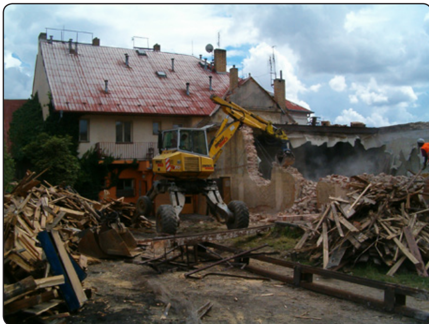
Během letních měsíců probíhaly demoliční práce na objektu bývalého kina. Jedná se o první část stavebních prací v rámci přestavby bývalého kina na víceúčelový objekt. Projekt je finančně podpořen dotací z ROP Jihozápad, termín dokončení je stanoven do dubna 2015.
