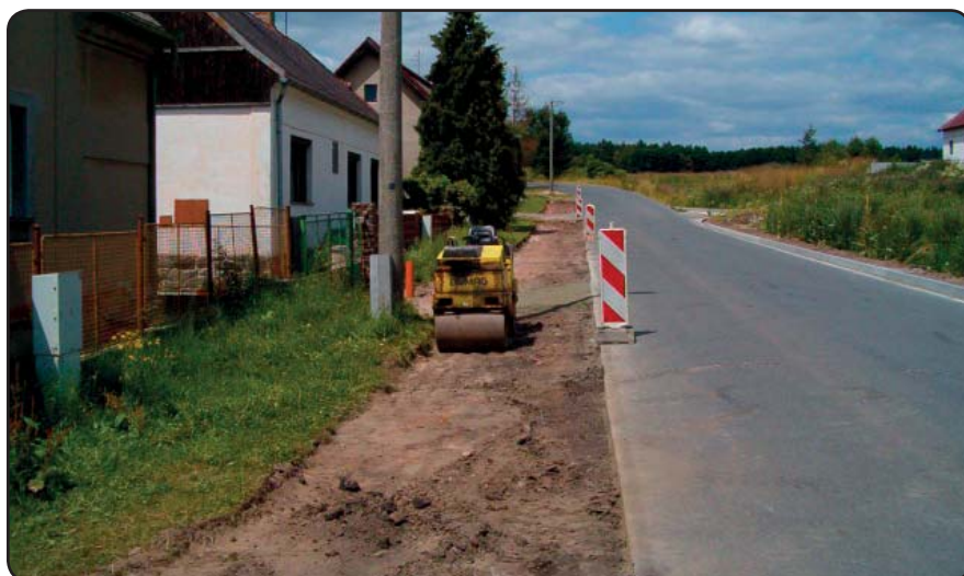
Zemní práce podél ulice Na Vypichu
