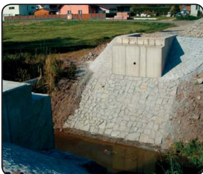
Stavební úpravy kolem pilířů budoucí lávky
