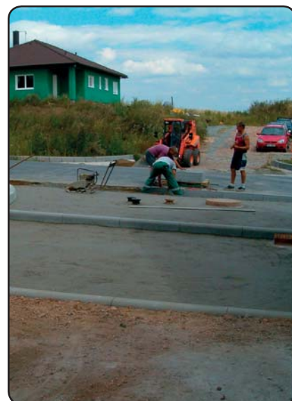
Práce na vjezdu do obytné zóny v ulici Pod Vrškem
