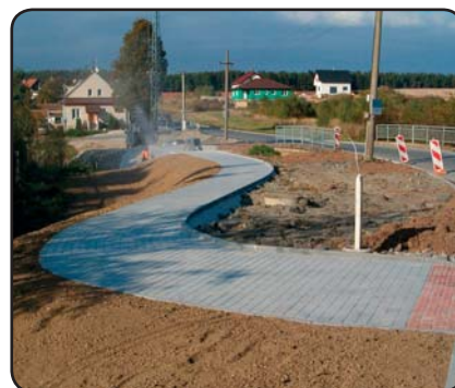
Chodník u Lučního potoka s čerstvě položenou dlažbou
