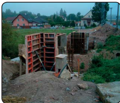
Budování pilířů lávky přes Luční potok
