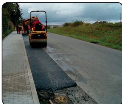
Asfaltování kraje silniční vozovky
