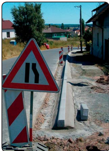
Osazování silničních obrubníků
