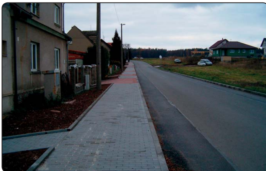
Dokončený chodník v ulici Na Vypichu
