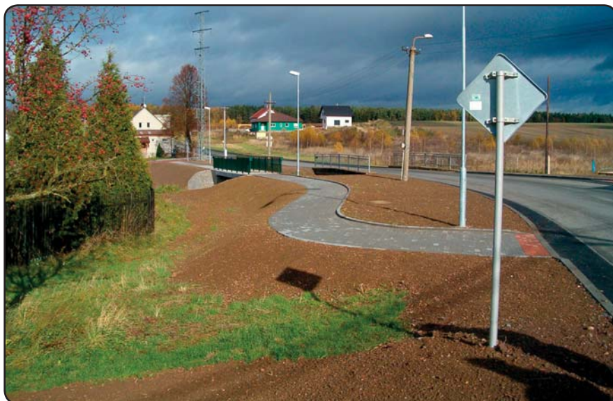
Bezbariérový chodník u Lučního potoka po dokončení
