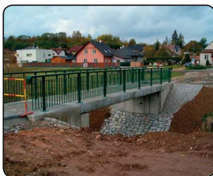
Lávka přes Luční potok s novým zábradlím
