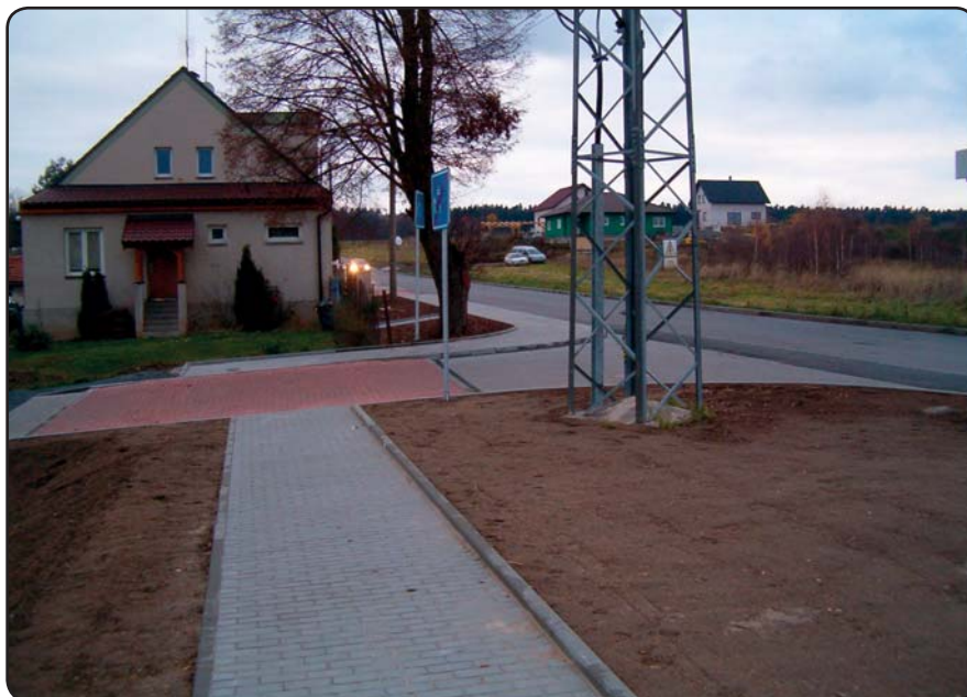
Dokončený vjezd do obytné zóny ve Slunečné ulici
