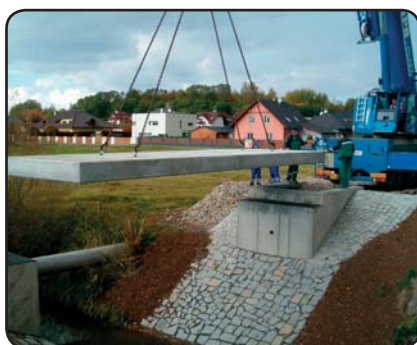
Osazování betonové mostovky autojeřábem
